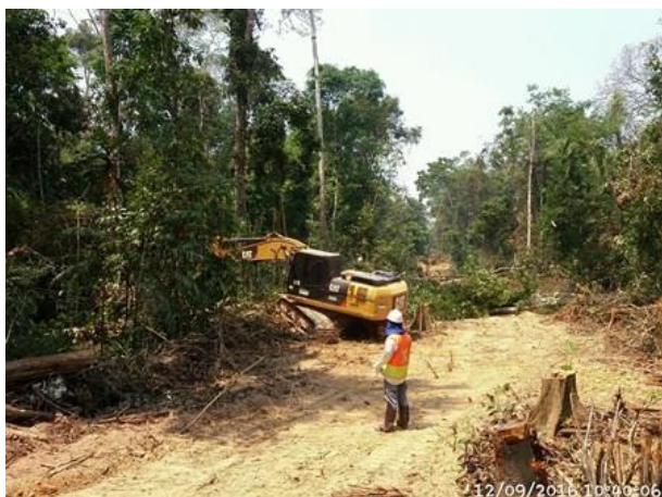
Figura - 1: Acompanhamento da supressão na área da LT.
