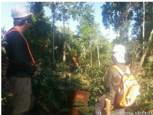
Figura - 3: Acompanhamento da supressão na área da LT.
