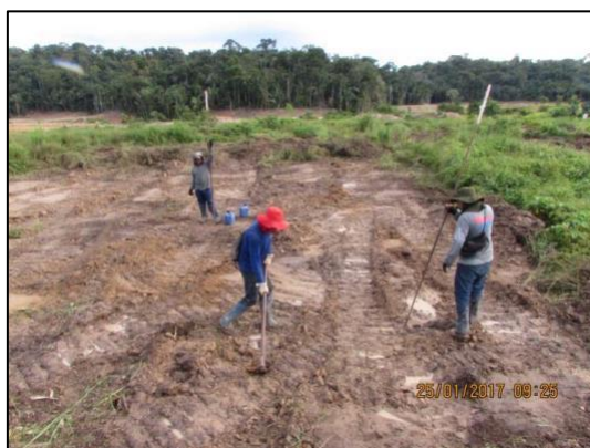
Figura - 6: Etapa de abertura do núcleo e roçada manual.
