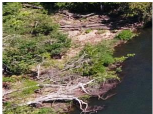
Figura 57: Ponto de instabilidade: queda de árvores por instabilidade da margem (Latitude: 09O 14' 51"; Longitude: 56O 51' 47").
