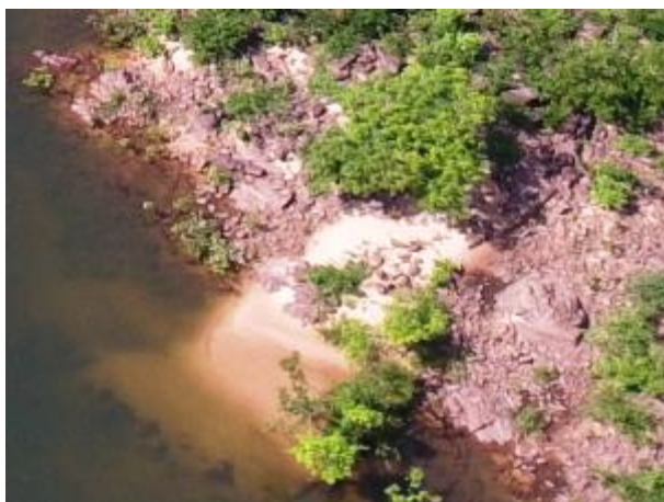
Figura 56: Ponto de instabilidade: processos erosivos e deslizamento de terra (Latitude: 0 9O 12' 42"; Longitude: 57O 02' 01").
