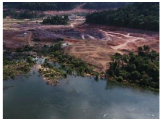
Figura 51: Ponto de instabilidade: canteiro de obras da UHE São Manoel (Latitude: 09O 11' 51"; Longitude: 57O 02' 29").
