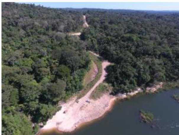
Figura 50: Ponto de instabilidade: construção de estradas. (Latitude: 09O 19' 53"; Longitude: 56O 46' 38").
