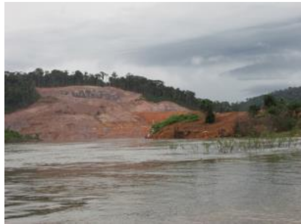
Figura 65: Registro Fotográfico: 43, Coordenadas UTM: 21 L 0495149-8983752. Caracterização: Área de supressão da vegetação.
