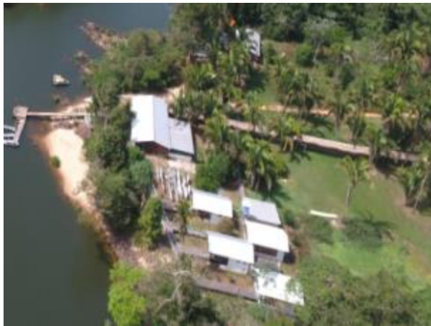
Figura 58: Ponto de instabilidade: alteração de APP por obras de recreação e lazer. (Latitude: 09O 13' 24''; Longitude: 57O 00' 51'').
