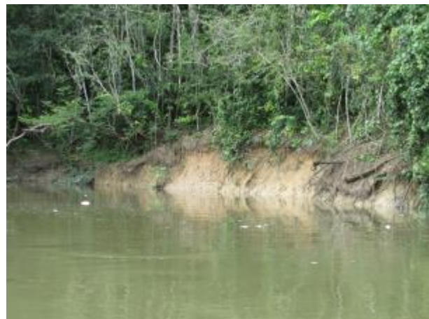
Figura 63: Registro Fotográfico: 15, Coordenadas UTM: 21L 0520824-8976323. Caracterização: Ponto de instabilidade natural com desbarrancamento.
