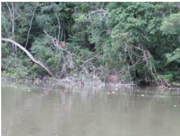
Figura 62: Registro Fotográfico: 05, Coordenadas UTM: 21L 0509288-8978961. Caracterização: Ponto de instabilidade com queda natural de árvores.
