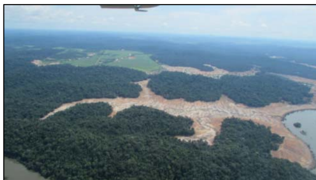
Figura 6: Vista aérea da ponta do Lote 02 e áreas adicionais. ASVs 1123/2016 e 1169/2016.
