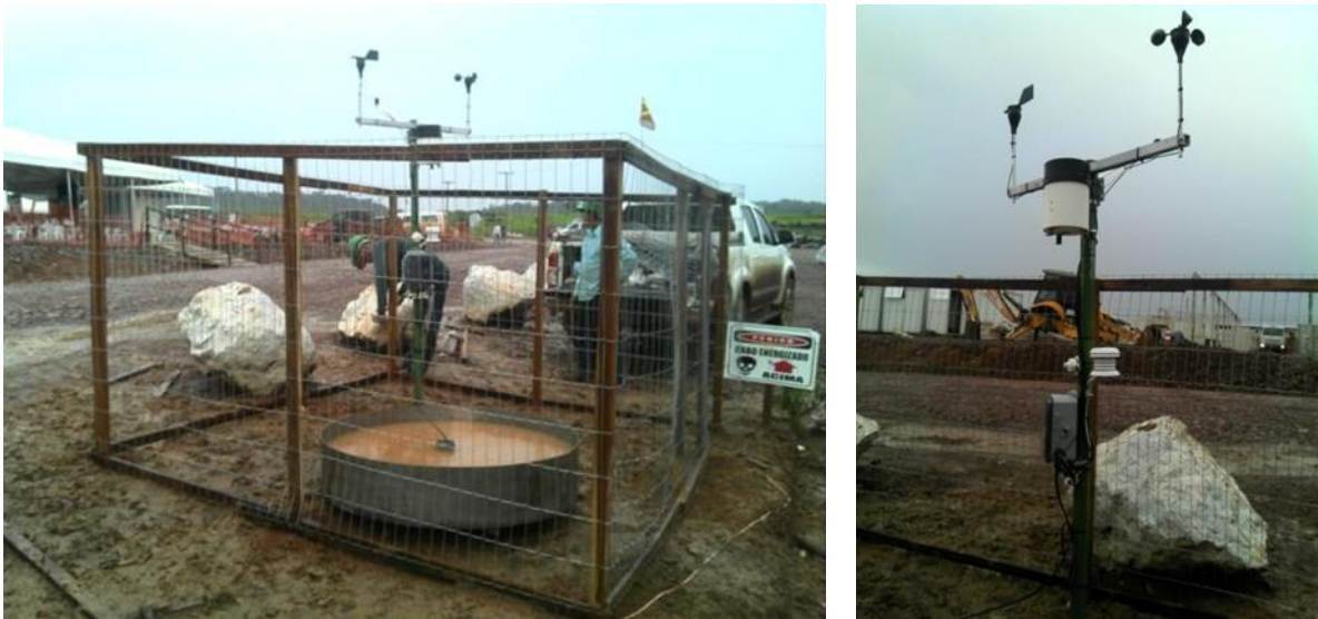
Figura 1. Imagens da instalação da estação meteorológica UHE São Manoel.
