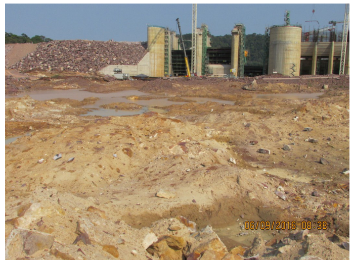
Foto IMG_02914 - Vista geral do sedimento movimentado.
