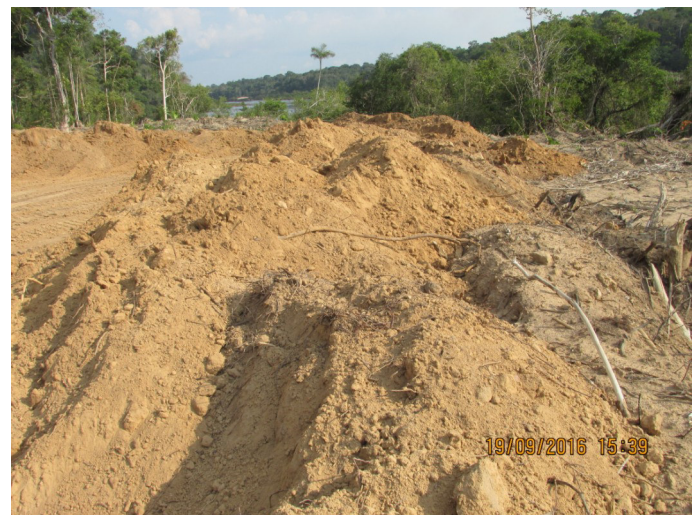
Foto IMG_02979 - Vista geral do sedimento movimentado.
