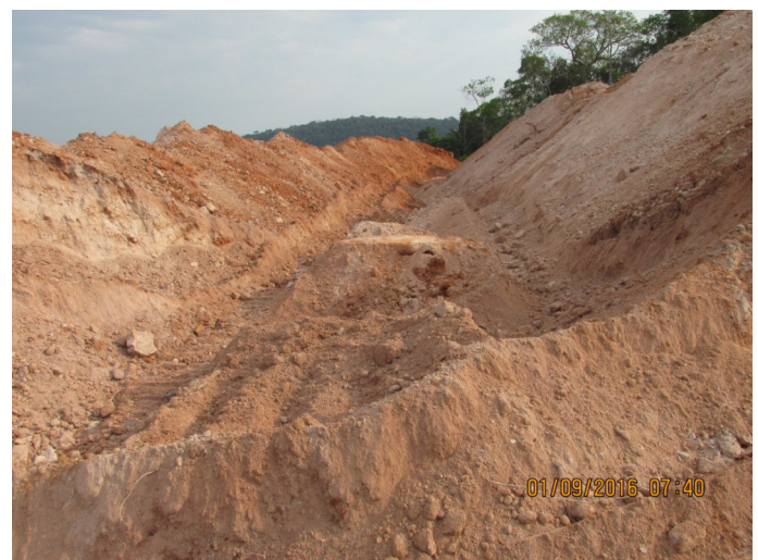
Foto IMG_02894 - Vista geral do sedimento movimentado.
