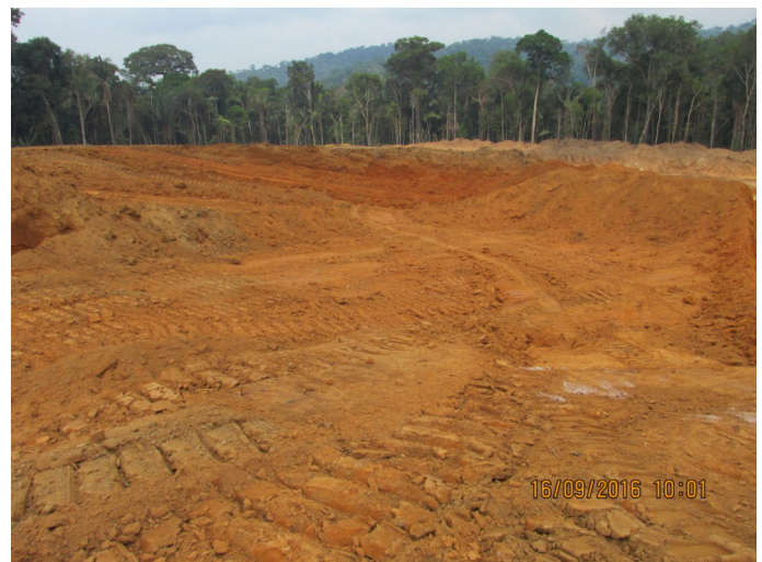
Foto IMG_02966 - Vista geral do sedimento movimentado.
