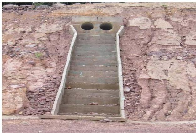
**Figura – 8: Bueiro com dissipador de energia.**
