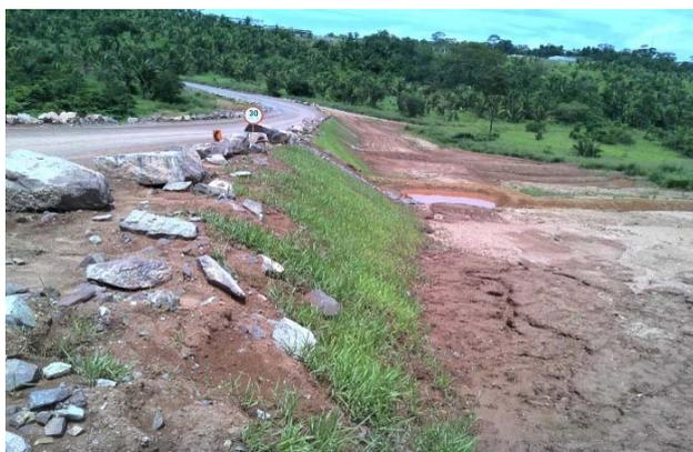
**Figura – 23: Talude semeado.**
