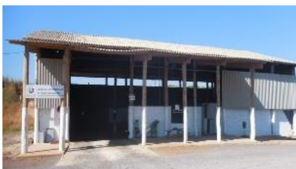
Figura 6: Vista do galpão de compostagem.
