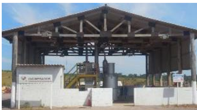
Figura 5 Vista do galpão do incinerador.
