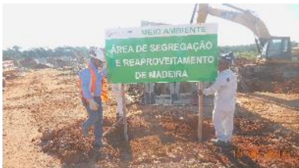
Figura 3: Área de segregação de madeira.
