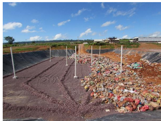
Figura 11: Vista da vala em operação.
