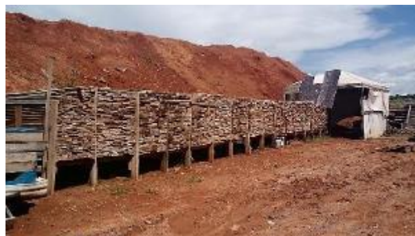
Figura 4: Madeira para reaproveitamento
