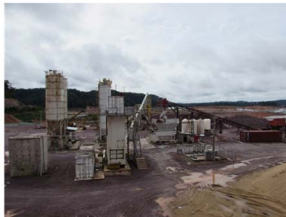
Figura - 90 - Silos fixados, estruturas em andamento de montagem.
