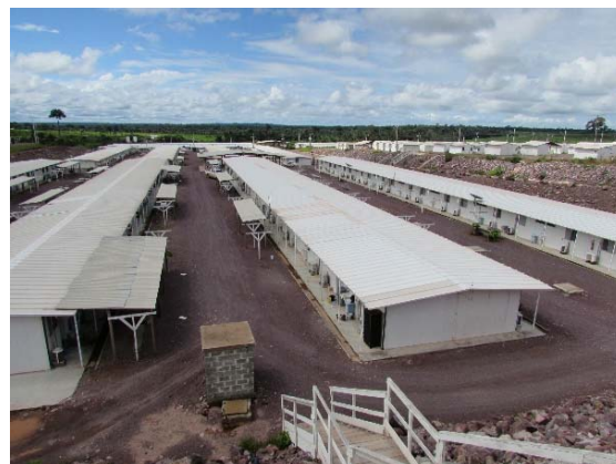
Figura - 5 - Vista ampla para o modelo padrão dos alojamentos construídos.
