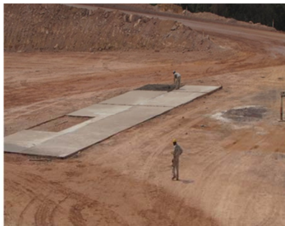
Figura - 85 - À esquerda, vista para platô antes de iniciar a montagem dos equipamentos. À direita, concretagem dos pisos.
