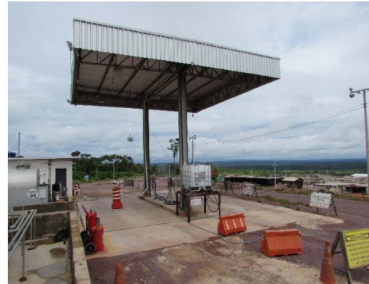
Figura - 37 Vista ampla para área de abastecimento.
