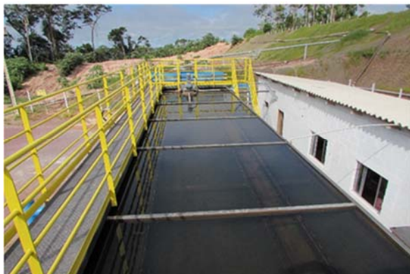
Figura - 28 -Mecanismos de floculação e decantação do tratamento de água (à esquerda); Mecanismo dos filtros em operação (à direita).
