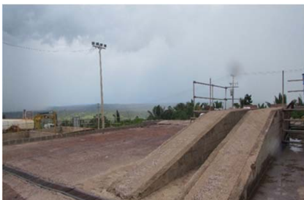
Figura - 21 - Instalações do galpão de lubrificação. Rampa de lavagem dos veículos e equipamentos (à esquerda); caixa separadora de água e óleo 20m³h (à direita).
