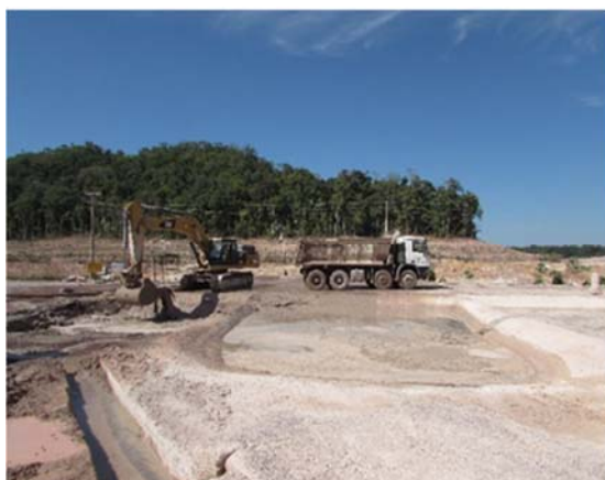
Figura - 84 - Remoção do material decantado para destinação em bota fora de concreto e Vista para procedimento de limpeza dos tanques de decantação.
