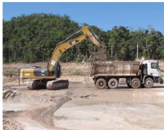
Figura - 84 - Remoção do material decantado para destinação em bota fora de concreto e Vista para procedimento de limpeza dos tanques de decantação.
