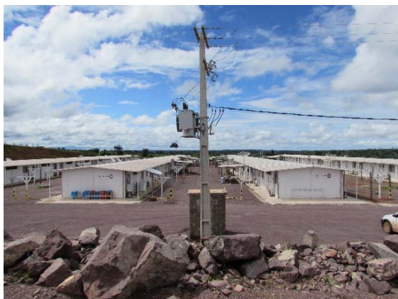
Figura - 4 - Vista frontal das entradas dos blocos de alojamentos.
