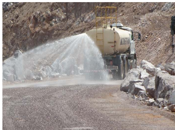
Figura - 54 - Umectação dos acessos.
