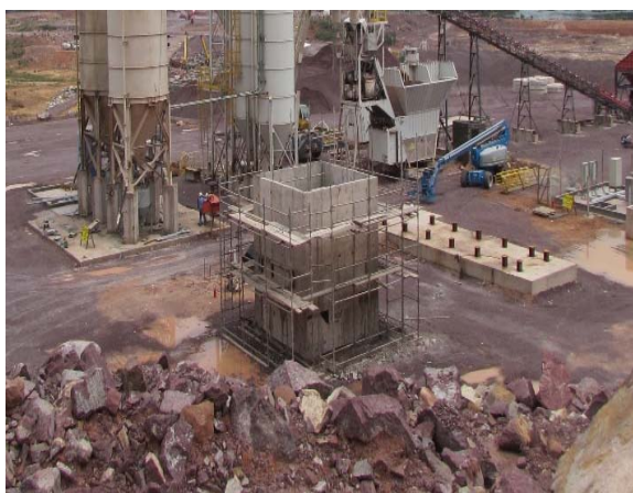
Figura - 91 - Construção da caixa para água, e base para acomodação em andamento.
