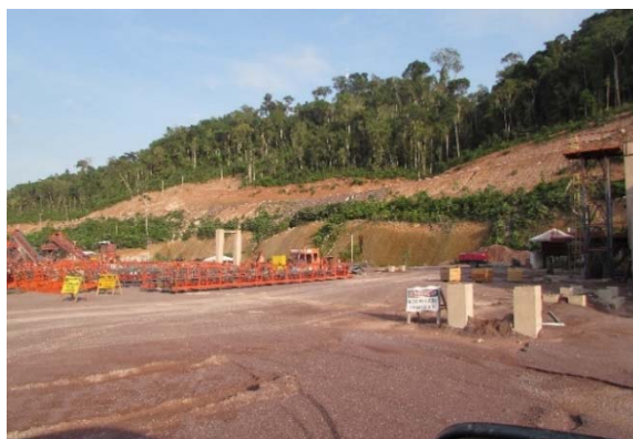
Figura - 69 - Peças desmontadas, aguardando carregamento para transporte.
