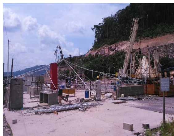
Figura - 81 - Processo em andamento da desmobilização das estruturas.
