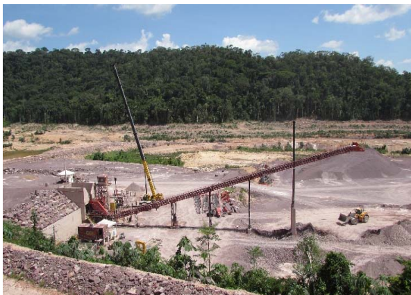
Figura - 66 Início do processo de desmobilização dos britadores central.
