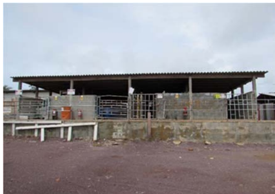
Figura - 44 - Baia produtos químicos em alvenaria localizada no almoxarifado.
