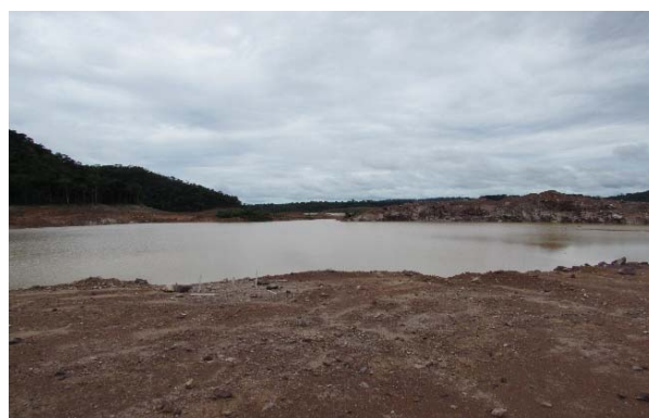
Figura - 46 Vista para P1 depois do desvio do rio de 2ª fase, dezembro 2016, mantendo conexão com o rio Teles Pires.
