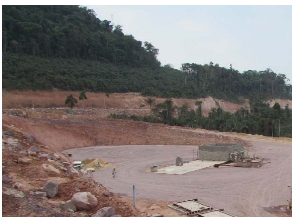
Figura - 86 Início da construção em alvenaria do laboratório.
