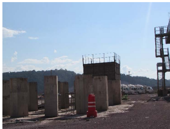
Figura - 79 - Vista da área com os equipamentos desmobilizados.
