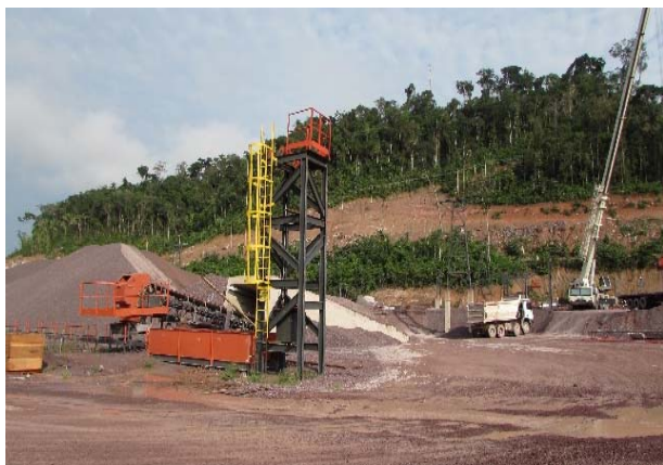
Figura - 70 - Andamento na etapa da desmobilização.
