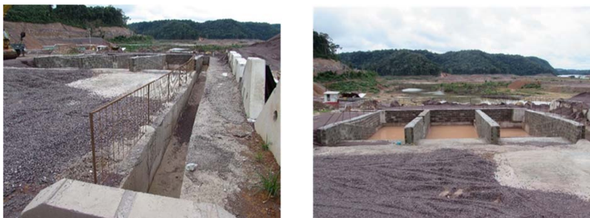
Figura - 94 –À esquerda: Canaleta de direcionamento da central de concreto conectado aos tanques do lavador de betoneira. À direita: vista ampla para os novos tanques lavador de betoneiras, instaladas na nova área industrial.
