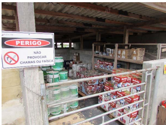
Figura - 42 - Baia de alvenaria fixa em frente de serviço.
