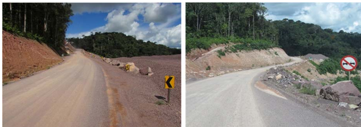
Figura - 2 - Vias de acesso. Trecho do acesso que faz conexão a área industrial (à esquerda); trecho de acesso ao circuito de geração (à direita).
