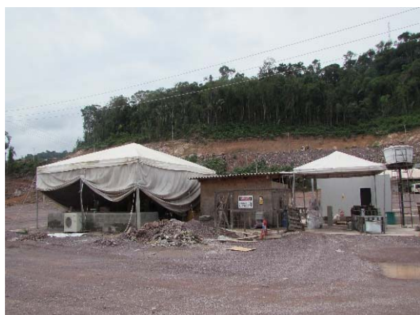
Figura - 80 - Laboratório civil em desmobilização.
