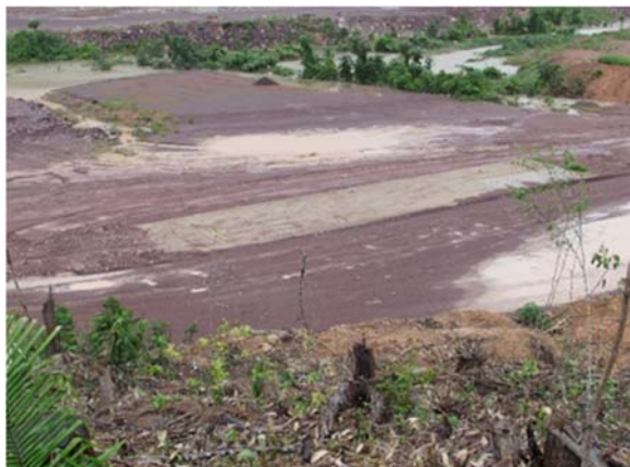
Figura - 82 - Vista da área com estruturas desmobilizadas.
