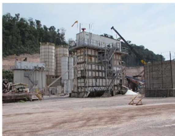
Figura - 77 - Central de gelo encerrando suas atividades para desmonte / relocação; à direita, atividade de desmonte das estruturas.
