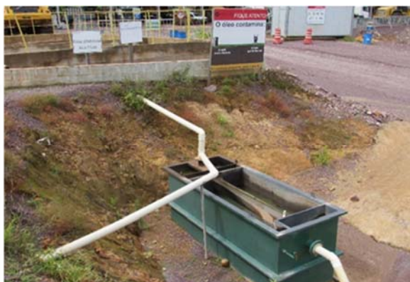
Figura - 21 - Instalações do galpão de lubrificação. Rampa de lavagem dos veículos e equipamentos (à esquerda); caixa separadora de água e óleo 20m³h (à direita).
