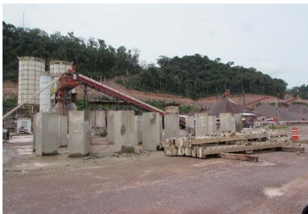
Figura - 78 - Peças desmontadas e aguardando transporte.
