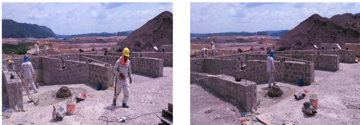
Figura - 93 - Realizando construção das divisões internas.
