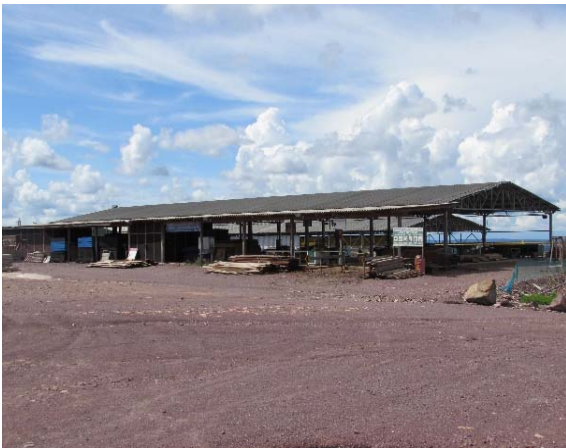
Figura - 57 Vista do galpão da carpintaria
