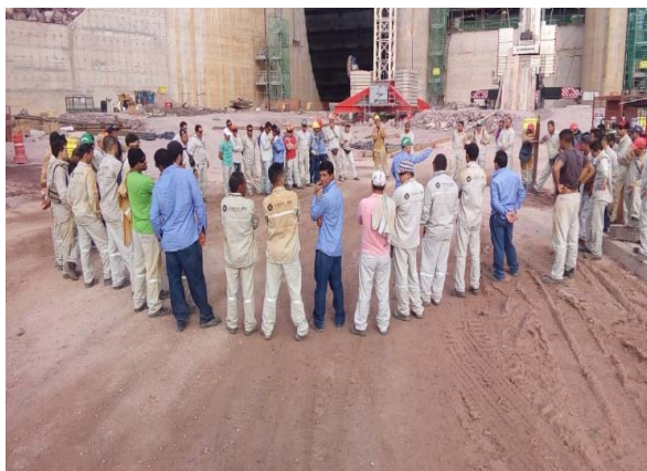
Figura - 96 Treinamento de meio Ambiente aplicado na frente e serviço setor da civil.
