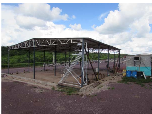
Figura - 24 - Galpão de manutenções da oficina de terceiros.
