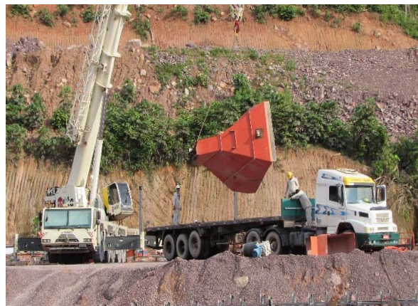
Figura - 71 - Carregamento e transporte das peças desmontadas.
