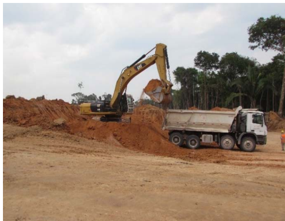
Figura - 48 - Vista geral da AE 06 em atividade.
