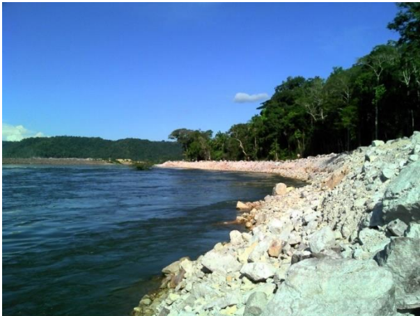
Figura 3.5: Margem esquerda do rio Teles Pires enrocada. Verificou-se que o enrocamento apresenta-se estável.
