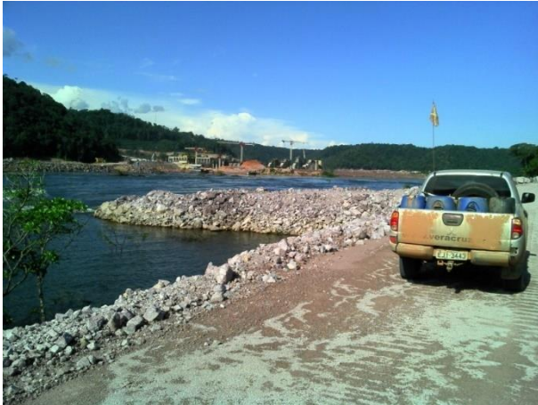
Figura 3.4: Margem esquerda do rio Teles Pires aterrada e enrocada. Verificou-se que o enrocamento inserido apresenta-se estável.
