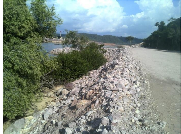
Figura 3.4: Margem esquerda do rio Teles Pires aterrada e enrocada. Verificou-se que o enrocamento inserido apresenta-se estável.
