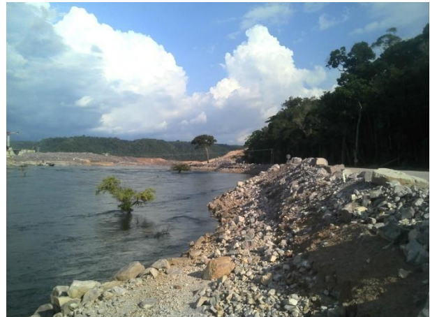
Figura 3.5: Margem esquerda do rio Teles Pires enrocada. Verificou-se que o enrocamento apresenta-se estável.
