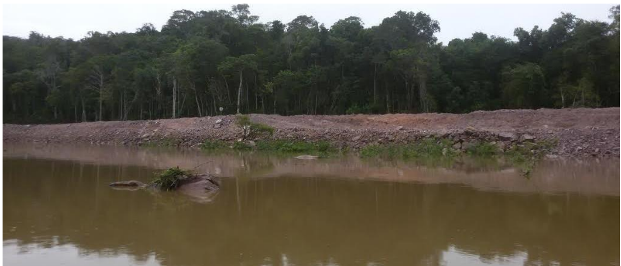
Figura 3.2: Vista geral da margem esquerda a jusante da barragem da UHE São Manoel no mês de dezembro de 2016.
