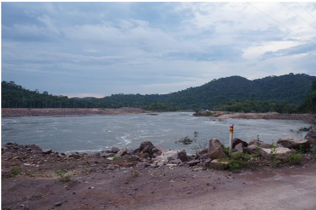
Figura 3.1: Vista geral da porção imediatamente a jusante da barragem da UHE São Manoel.
