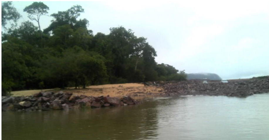
Figura 3.8: Solo exposto em porção localizada do talude nas coordenadas UTM WGS 84 21L 493518 8984799.
