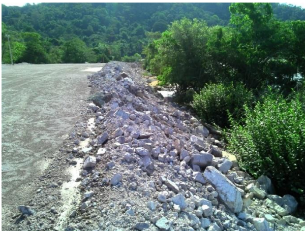
Figura 3.6: Talude enrocado na margem esquerda do rio Teles Pires. Verificou-se que o enrocamento apresenta-se estável.
