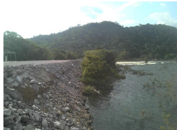
Figura 3.6: Talude enrocado na margem esquerda do rio Teles Pires. Verificou-se que o enrocamento apresenta-se estável.
