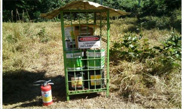
**Figura - 50: Estrutura para armazenamento de produtos químicos.**
