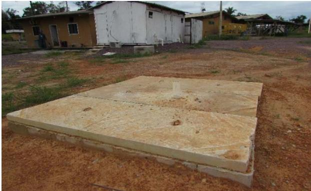
**Figura - 32: Estrutura de tanque séptico impermeabilizado para retenção de efluentes sanitários no Canteiro da LT.**
