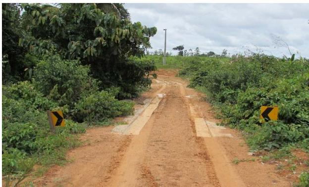
**Figura - 8: Estrutura de ponte de madeira existente reforçada em acesso existente.**
