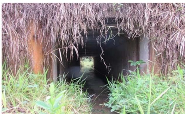
**Figura - 2: Acesso existente com disposição de bueiro tubular para passagem de água (à
