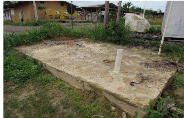
**Figura - 33: Estrutura de tanque séptico impermeabilizado para retenção de efluentes sanitários no Canteiro da LT.**
