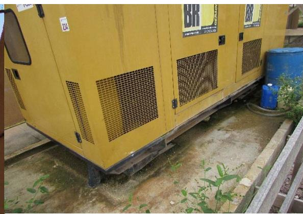
**Figura - 13: Detalhe da proteção para gerador fixo motor ciclo a diesel.**
