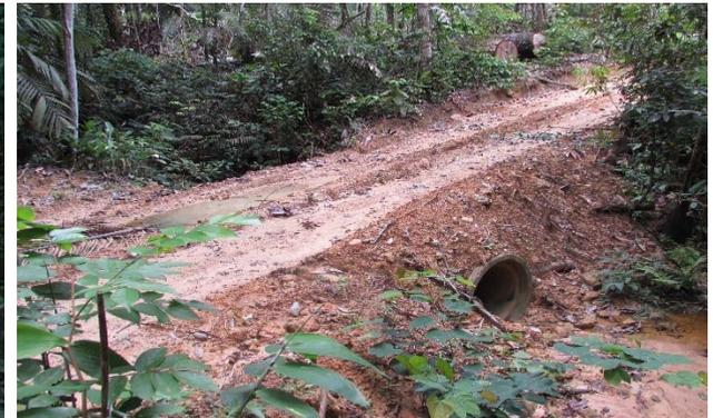
**Figura - 7: Vista da instalação de bueiro tubular na faixa de servidão da LT.**
