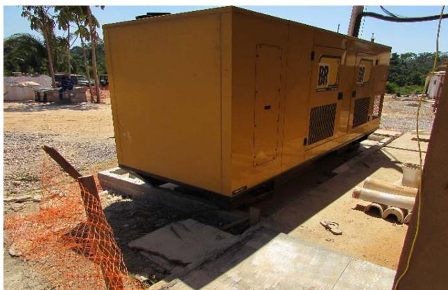
**Figura - 12: Vista do gerador com dispositivo de controle em piso de concreto.**
