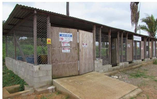
**Figura - 44: Detalhe para baia de armazenamento de produtos perigosos integrada com a baia de resíduos.**
