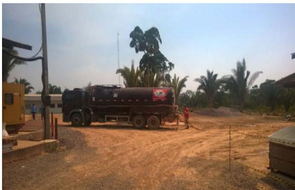
**Figura - 34: Processo de esgotamento de efluentes sanitários no Canteiro da LT.**
