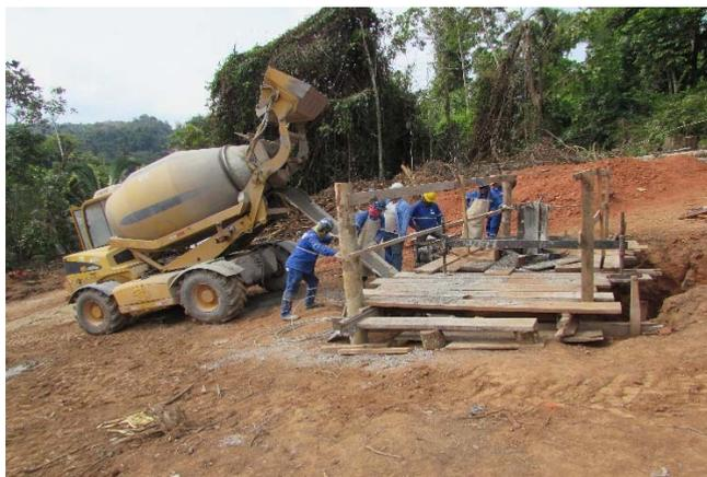
**Figura - 10: Autobetoneira compacta em lançamento de concreto.**
