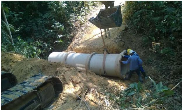
**Figura - 6: Vista da instalação de bueiro tubular na faixa de servidão da LT.**
