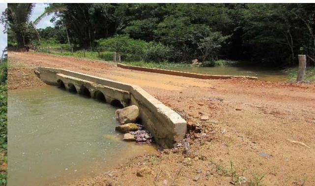
**Figura - 9: Estrutura de bueiro tubular instalado em acesso existente.**
