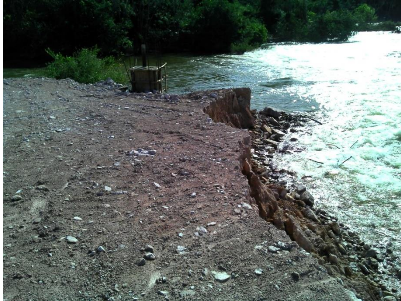
Figura 4.18: Margem aterrada erodida nas proximidades da foz do rio Apicás. Verificou-se que o enrocamento inserido nas margens foi carregado pelas altas vazões do rio Teles Pires.
