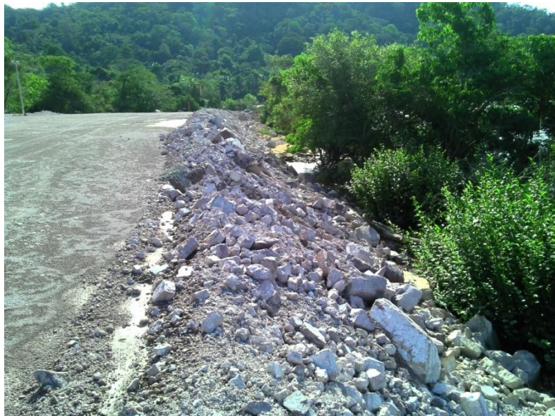
Figura 4.21: Talude enrocado nas proximidades do ponto 2 ilustrado no mapa da Figura 4.22. Verificou-se que o enrocamento apresenta-se estável.
