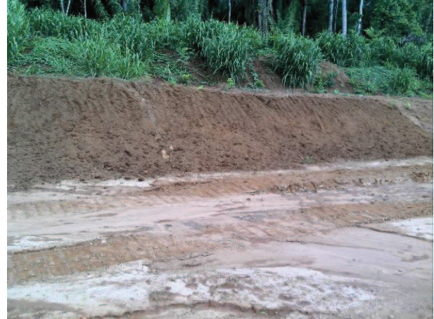
Figura 137: Conformação de terreno – “Acesso A”
