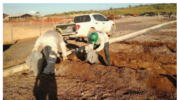
Figura 114: Tratamento de solo contaminado
