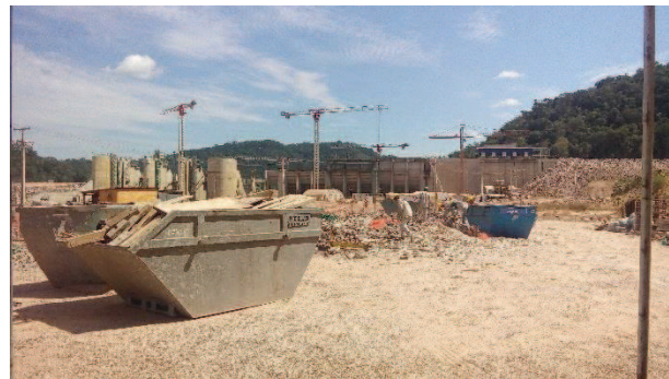
Figura 100: Vista da operação da Área de segregação avançada
