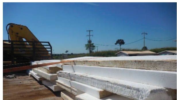
Figura 132: Retirada de placa isopor para utilização na obra.
