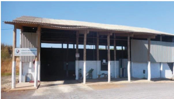
Figura 121: Vista do galpão de compostagem.
