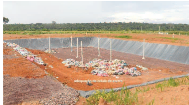
Figura 127: Vista da segunda vala de aterro
