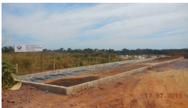
Figura 113: Landfarm – biorremediação.
