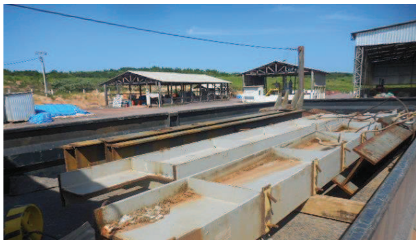
Figura 131: Retirada de metais para reaproveitamento na obra.
