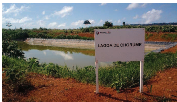
Figura 128: Vista da Lagoa de chorume
