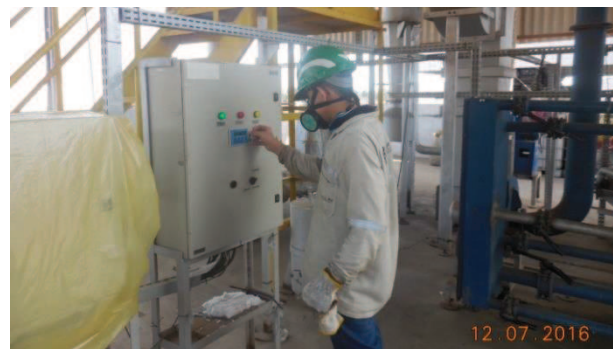
Figura 119: Operador do incinerador
