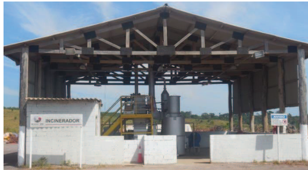
Figura 117: Vista do galpão do incinerador.
