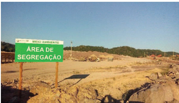
Figura 99: Sinalização da Área de segregação avançada
