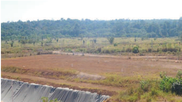
Figura 126: Vista da vala 01 - recuperada
