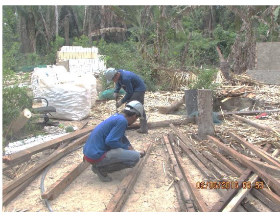
Figura 2-8: Mudança e demolição “Ilha do Josué”
