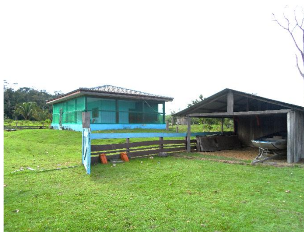
Figura 2-2: Vista parcial da propriedade: Sérgio Alexandre Araldi
