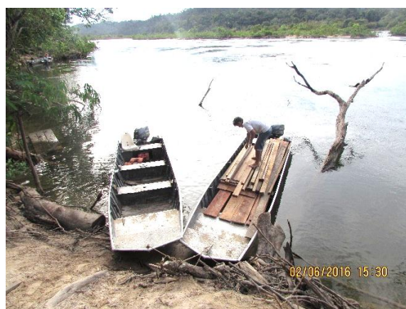
Figura 2-9: Mudança e demolição “Ilha do Josué”
