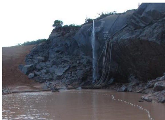
Figura 4: Água de retorno e aeração da água retida na ensecadeira, UHE São Manoel, Mai-Jun/2016.
