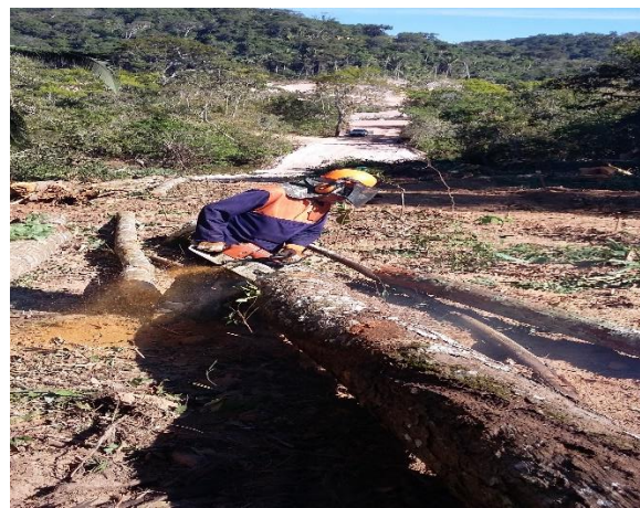
Figura 13-10 – Destopamento e Traçamento
