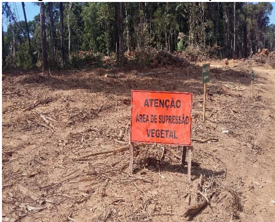
Figura 13-1 – Sinalização das frentes de supressão vegetal.
