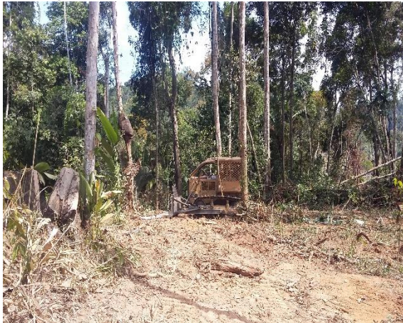
Figura 13-5 – Bosqueamento mecanizado
