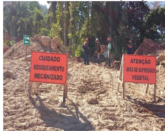
Figura 13-2 - Sinalização das frentes de supressão vegetal.
