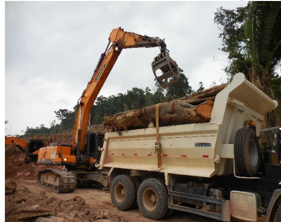
Figura 13-12 - Carregamento e transporte de toras nas esplanadas para o pátio final.
