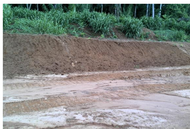
Figura 3.3.3.3-3 Conformação de terreno – “Acesso A”
