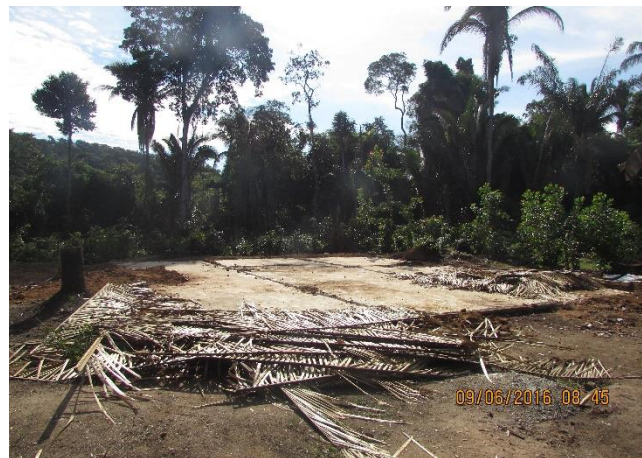
Figura 3.13-4 - Vista geral das edificações demolidas na propriedade SMI001I.
