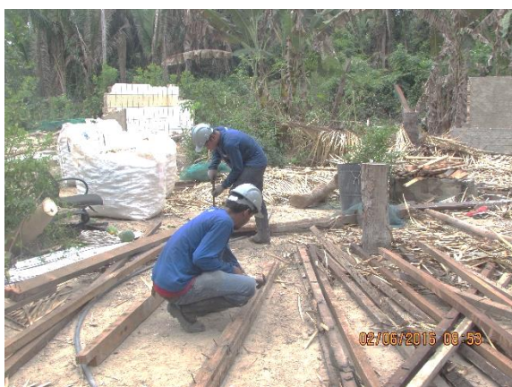
Figura 3.28.1-1: Mudança e demolição “Ilha do Josué”
