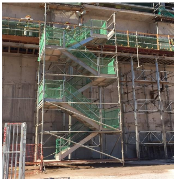
Figura 3.3.4.4: Escada de acesso conforme NR 18 Figura 3.3.4.5: Escada de acesso conforme NR 18
