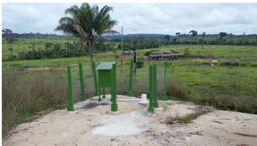
Figura 3.4-1: Vista geral da estação implantada sobre maciço rochoso.
