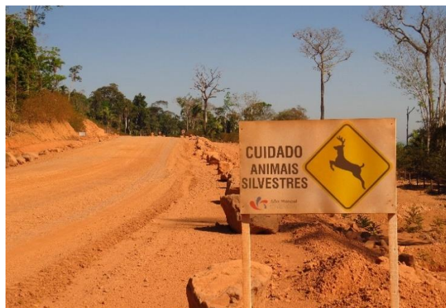
Figura 3.18.3-9: Placa alertando sobre a travessia de animais silvestres na via de acesso a UHE São Manoel.
