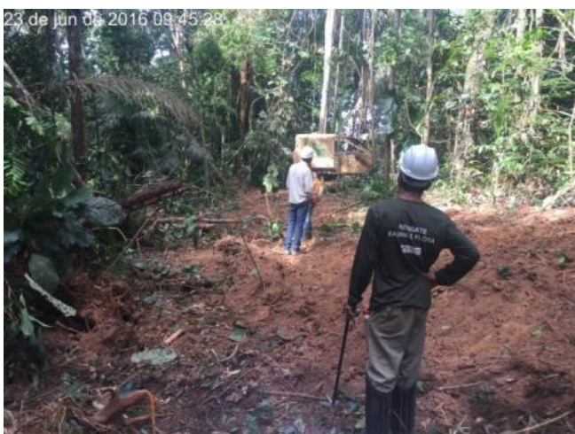
Figura 3.18-1: Supressão vegetal acompanhada por equipe de resgate de fauna.
