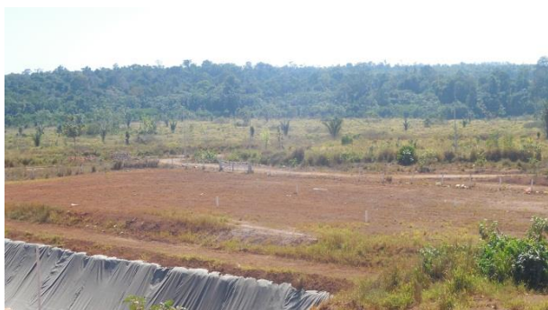
Figura 3.3.2.1-9: Vista da vala 01 - recuperada
