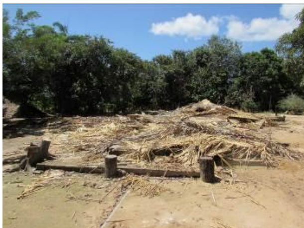
Figura 3.13-5 - Vista geral das edificações demolidas na propriedade SMO001E.
