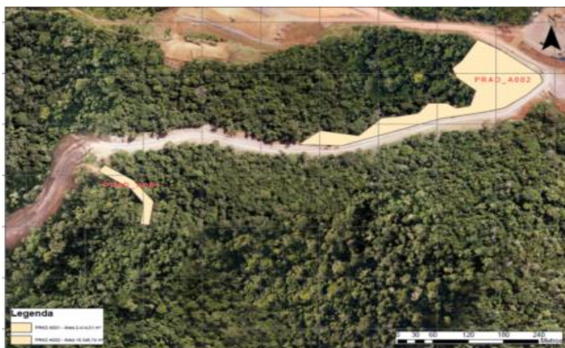
Figura 3.3.3.3-1 - Áreas de plantio de mudas no canteiro de obra
