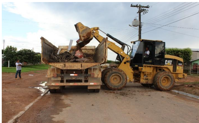
Figura 3.34-1 - Carregamento de entulhos na área urbana de Paranaitá
