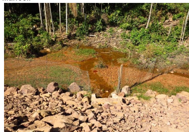
Figura 3.18.3-12: Instalação de cercas guias para os animais, com uso de alambrado junto a estrutura da passagem de fauna (A).
