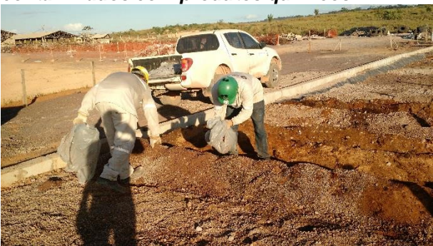
Figura 3.3.2.1-5: Tratamento de solo contaminado
