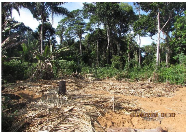
Figura 3.13-3 - Vista geral das edificações demolidas na propriedade SMI001I.
