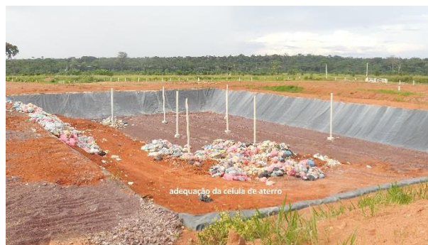
Figura 3.3.2.1-10: Vista da segunda vala de aterro
