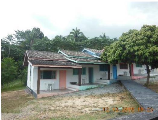
Figura 2-6: Estruturas da Pousada Jersusalem.
