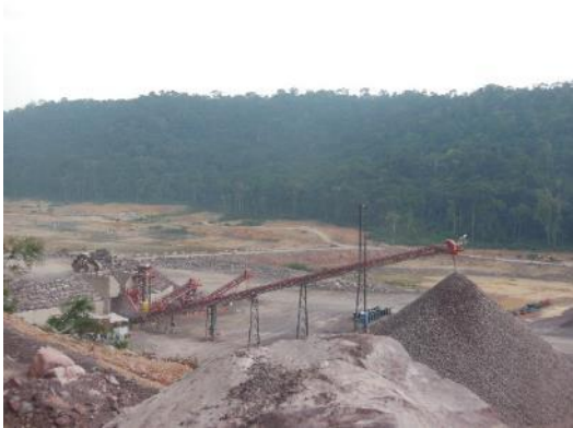
Figura 2-2: Canteiro de Obras da UHE São Manoel.
