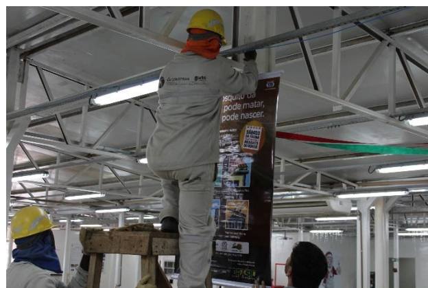
Figura 2-43: Instalação do banner no refeitório.
