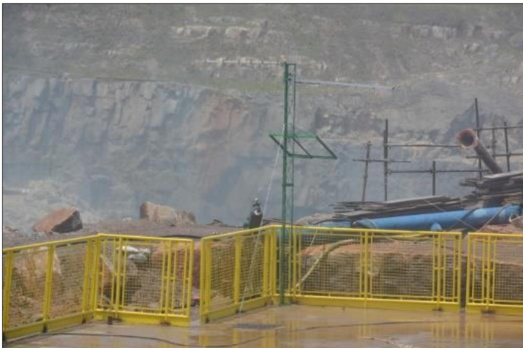
**Figura 1-6: Estação pronta, faltando apenas a caixa de montagem e painel solar que serão instalados na próxima campanha, junto com os equipamentos eletroeletrônicos.**
