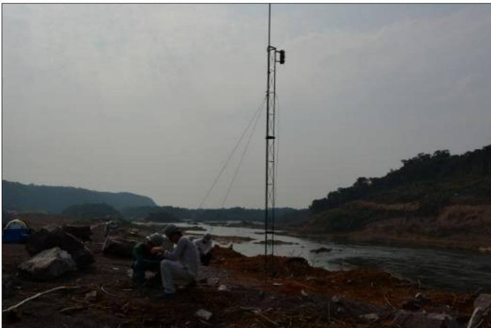
**Figura 1-8: Visão geral da estação já erguida, sendo estabilizada pelos cabos de aço.**
