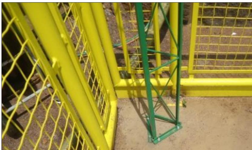
**Figura 1-4:Detalhe da fixação da torre ao chão, usando buchas chumbadoras.**
