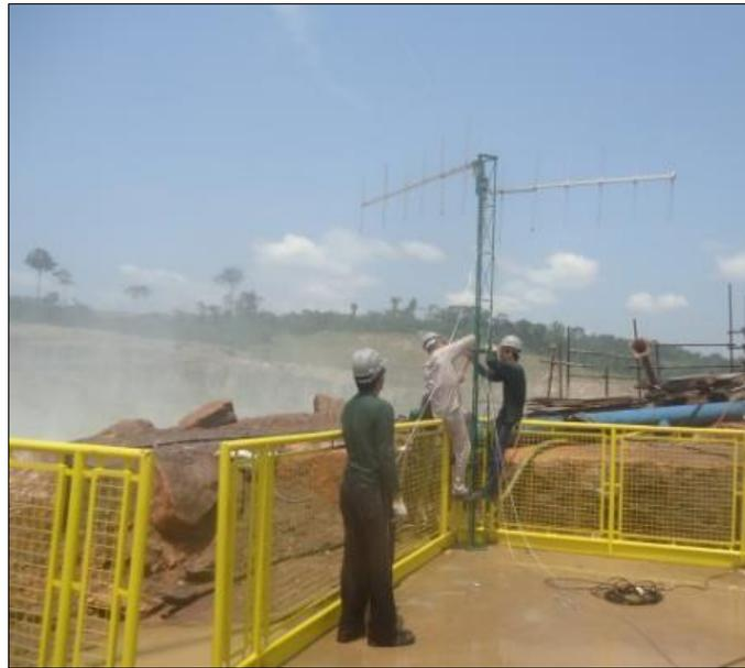
**Figura 1-5: Fixação do módulo superior e preparação do cabo de aço para fixação.**
