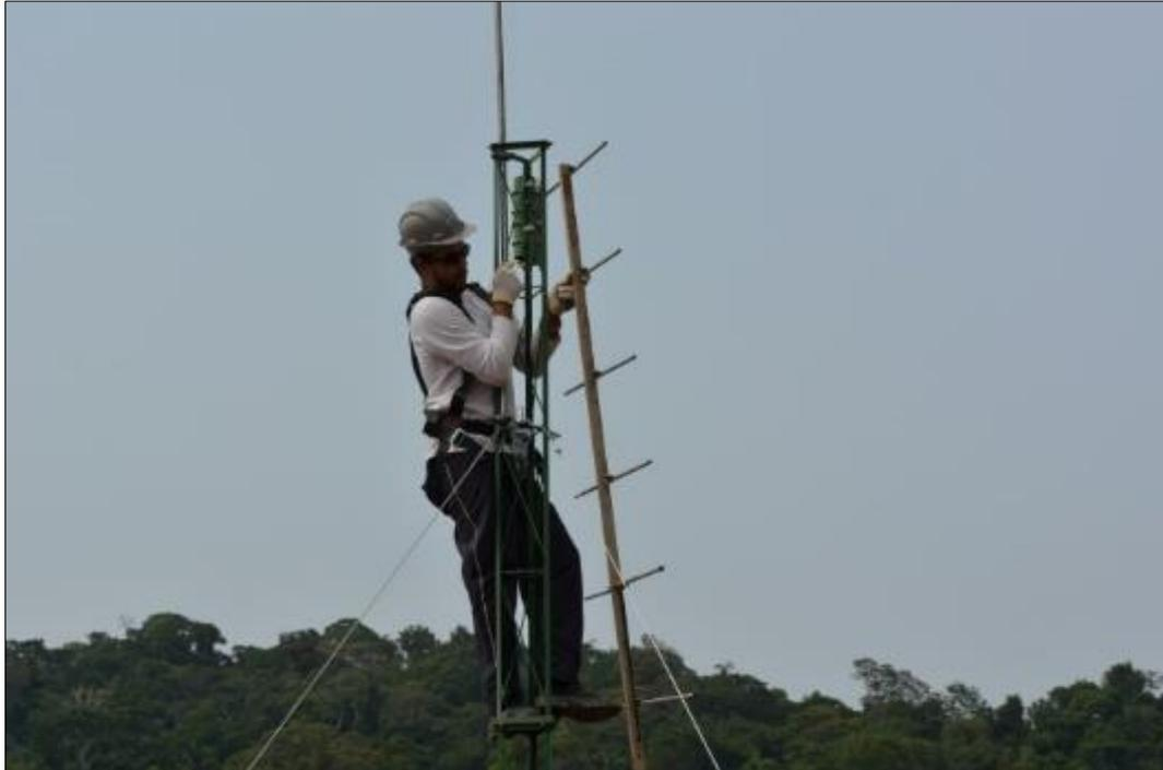
**Figura 1-10: Fixação da antena de rádio telemetria à torre da estação.**
