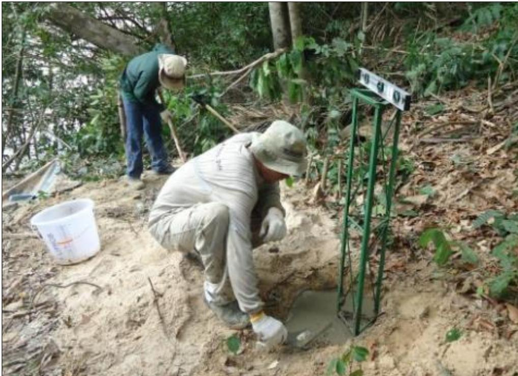
**Figura 1-13:** Término da fundação da base da torre, com o detalhe do nível usado para garantir o nivelamento da torre.
