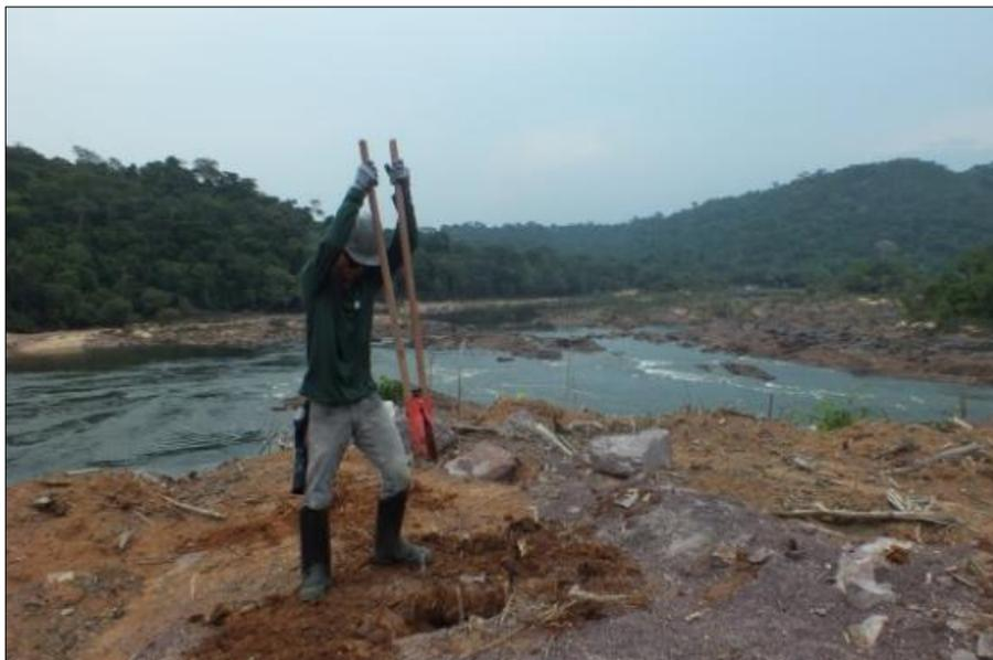
**Figura 1-7: Escavação da fundação da torre da Estação 02.**
