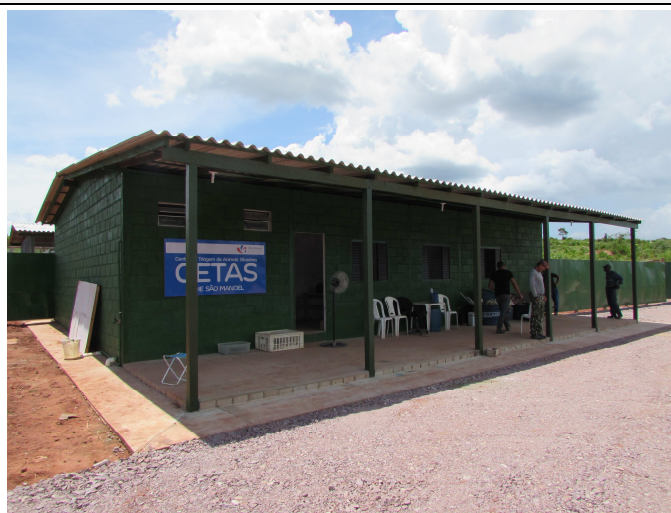
Foto 01 – VISTA GERAL DO CENTRO DE TRIAGEM
