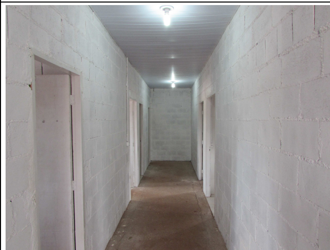
Foto 08 – VISTA DO CORREDOR INTERNO DO CENTRO DE TRIAGEM
