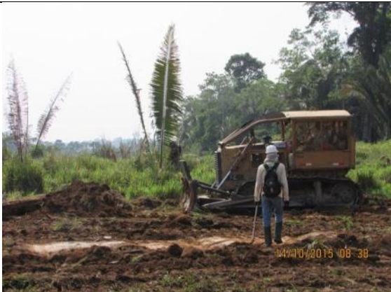
Figura 195: Acompanhamento das atividades de supressão vegetal mecanizada no Acesso Principal durante o 15º mês do Programa de Resgate e Salvamento Científico da Fauna na área de instalação do canteiro de obras da UHE São Manoel.
