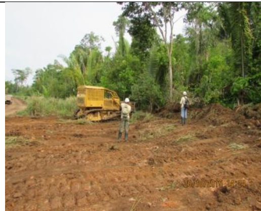
Figura 204: Acompanhamento das atividades de supressão vegetal mecanizada no Acesso Principal durante o 15º mês do Programa de Resgate e Salvamento Científico da Fauna na área de instalação do canteiro de obras da UHE São Manoel.
