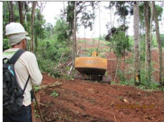
Figura 248: Acompanhamento de supressão vegetal mecanizada no acesso principal durante o 16º mês do Programa de Resgate e Salvamento Científico da Fauna na área de instalação do canteiro de obras da UHE São Manoel.
