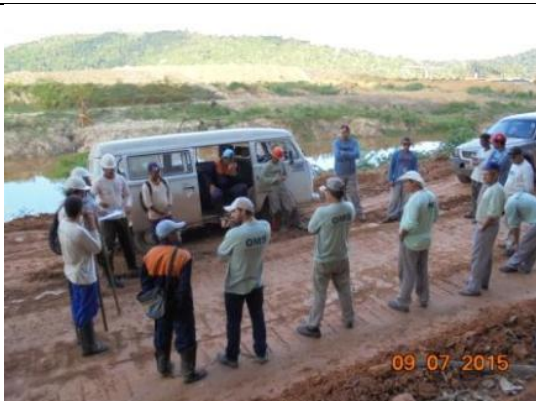
Figura 25: DDS sendo realizado durante o 12º mês do Programa de Resgate e Salvamento Científico da Fauna na área de instalação do canteiro de obras da UHE São Manoel.
