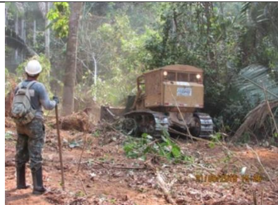
Figura 138: Acompanhamento das atividades de supressão mecanizada no Acesso A durante o 14º mês do Programa de Resgate e Salvamento Científico da Fauna na área de instalação do canteiro de obras da UHE São Manoel.
