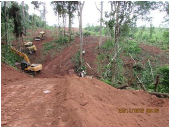
Figura 247: Acompanhamento de supressão vegetal mecanizada no acesso principal durante o 16º mês do Programa de Resgate e Salvamento Científico da Fauna na área de instalação do canteiro de obras da UHE São Manoel.
