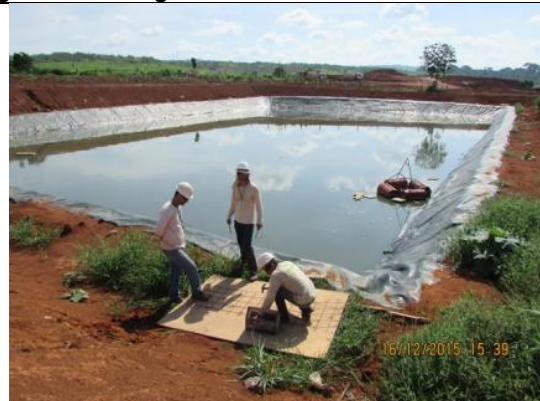
Figura 280: Construção de estrutura de fuga para Hydrochoerus hydrochaeris presa em barragem de chorume na ETA São Manoel durante o 17º mês do Programa de Resgate e Salvamento Científico da Fauna na área de instalação do canteiro de obras da UHE São Manoel.
