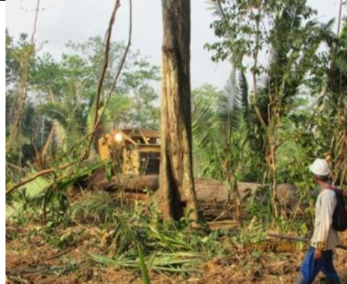
Figura 142: Acompanhamento das atividades de supressão mecanizada no Acesso A durante o 14º mês do Programa de Resgate e Salvamento Científico da Fauna na área de instalação do canteiro de obras da UHE São Manoel.
