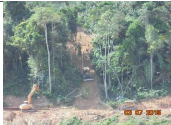
Figura 10: Acompanhamento da retirada de madeira em abertura pela mata durante o 12º mês do Programa de Resgate e Salvamento Científico da Fauna na área de instalação do canteiro de obras da UHE São Manoel.
