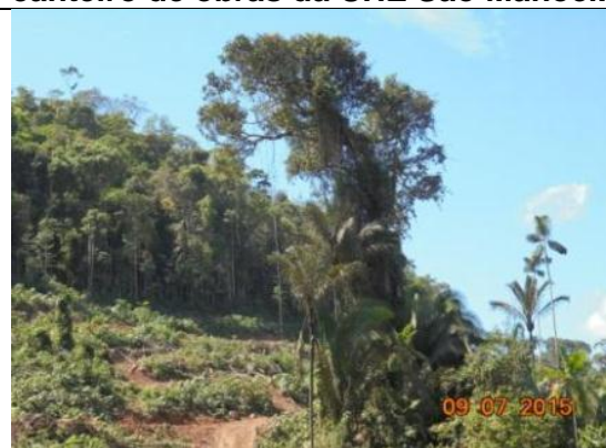
Figura 28: Acompanhamento da supressão do acesso de número 3 sendo finalizada durante o 12º mês do Programa de Resgate e Salvamento Científico da Fauna na área de instalação do canteiro de obras da UHE São Manoel.
