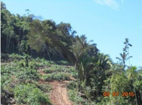
Figura 29: Castanheira sendo derrubada por motosserrista durante o 12º mês do Programa de Resgate e Salvamento Científico da Fauna na área de instalação do canteiro de obras da UHE São Manoel.
