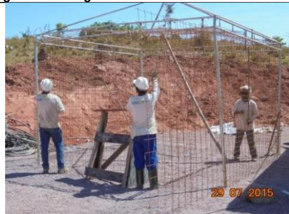
Figura 108: Construção de um viveiro pela equipe Biocev, mediante doação de material pela Constran durante o 12º mês do Programa de Resgate e Salvamento Científico da Fauna na área de instalação do canteiro de obras da UHE São Manoel.
