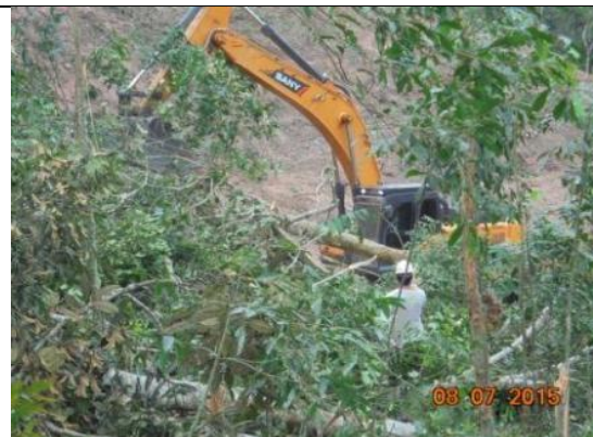
Figura 22: Acompanhamento da supressão sendo realizada com escavadeira hidráulica durante o 12º mês do Programa de Resgate e Salvamento Científico da Fauna na área de instalação do canteiro de obras da UHE São Manoel.
