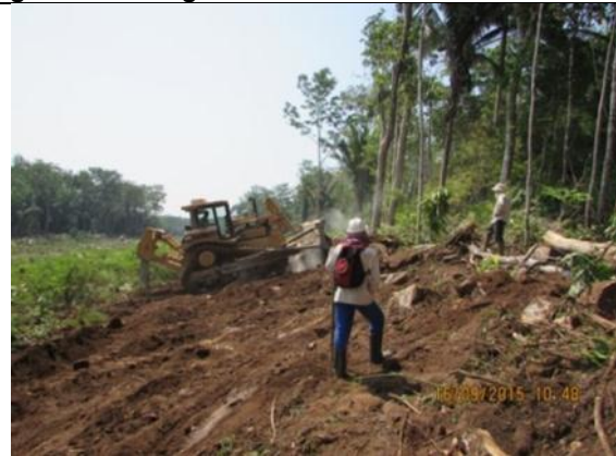
Figura 136: Acompanhamento das atividades de supressão mecanizada no Acesso A durante o 14º mês do Programa de Resgate e Salvamento Científico da Fauna na área de instalação do canteiro de obras da UHE São Manoel.
