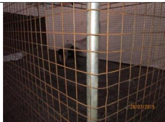
Figura 106: Construção de um viveiro pela equipe Biocev, mediante doação de material pela Constran durante o 12º mês do Programa de Resgate e Salvamento Científico da Fauna na área de instalação do canteiro de obras da UHE São Manoel.
