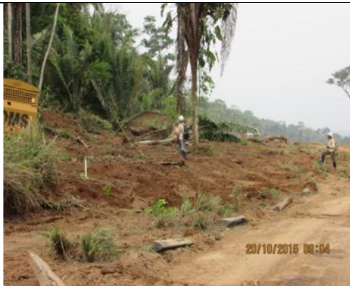
Figura 203: Acompanhamento das atividades de supressão vegetal mecanizada no Acesso Principal durante o 15º mês do Programa de Resgate e Salvamento Científico da Fauna na área de instalação do canteiro de obras da UHE São Manoel.
