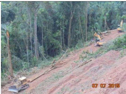
Figura 19: Acompanhamento da separação e arraste de toras durante o 12º mês do Programa de Resgate e Salvamento Científico da Fauna na área de instalação do canteiro de obras da UHE São Manoel.
