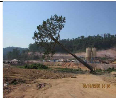
Figura 200: Acompanhamento das atividades de supressão vegetal manual no canteiro durante o 15º mês do Programa de Resgate e Salvamento Científico da Fauna na área de instalação do canteiro de obras da UHE São Manoel.
