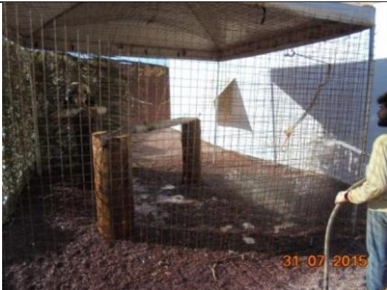
Figura 129: Umidificação diária do recinto da harpia durante o 12º mês do Programa de Resgate e Salvamento Científico da Fauna na área de instalação do canteiro de obras da UHE São Manoel.
