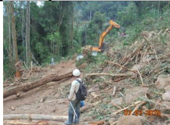
Figura 18: Acompanhamento da separação de toras e refugo vegetal durante o 12º mês do Programa de Resgate e Salvamento Científico da Fauna na área de instalação do canteiro de obras da UHE São Manoel.
