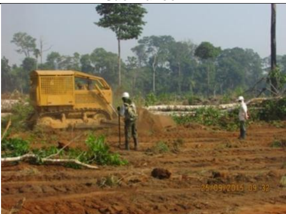
Figura 151: Acompanhamento das atividades de supressão mecanizada no Acesso A durante o 14º mês do Programa de Resgate e Salvamento Científico da Fauna na área de instalação do canteiro de obras da UHE São Manoel.
