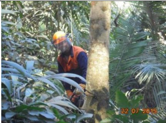
Figura 83: Acompanhamento da supressão por motosserrista durante o 12º mês do Programa de Resgate e Salvamento Científico da Fauna na área de instalação do canteiro de obras da UHE São Manoel.
