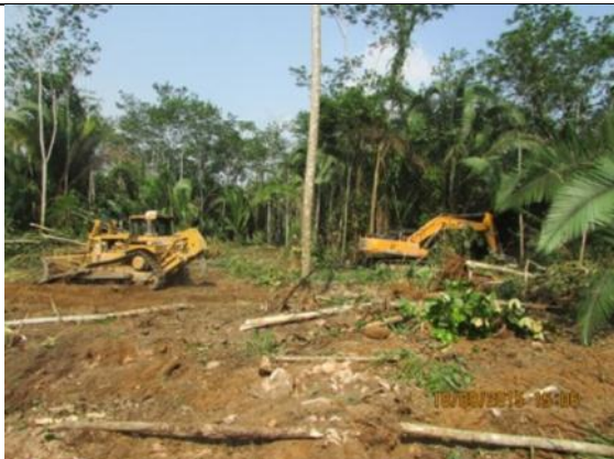
Figura 137: Acompanhamento das atividades de supressão mecanizada no Acesso A durante o 14º mês do Programa de Resgate e Salvamento Científico da Fauna na área de instalação do canteiro de obras da UHE São Manoel.
