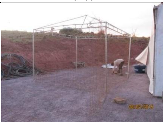
Figura 105: Construção de um viveiro pela equipe Biocev, mediante doação de material pela Constran durante o 12º mês do Programa de Resgate e Salvamento Científico da Fauna na área de instalação do canteiro de obras da UHE São Manoel.
