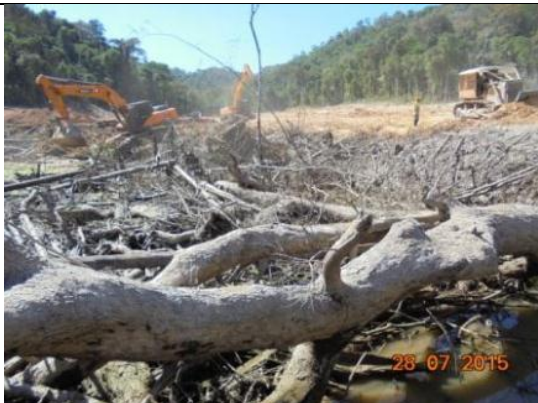
Figura 103: Atividades na área do lago represado, após o esvaziamento, durante o 12º mês do Programa de Resgate e Salvamento Científico da Fauna na área de instalação do canteiro de obras da UHE São Manoel.
