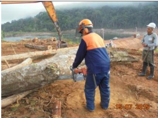
Figura 37: Acompanhamento do corte e retirada de toras da área suprimida na ilha durante o 12º mês do Programa de Resgate e Salvamento Científico da Fauna na área de instalação do canteiro de obras da UHE São Manoel.
