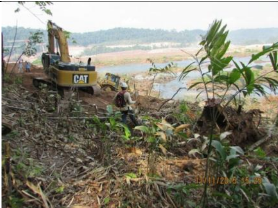
Figura 237: Acompanhamento de supressão vegetal mecanizada na margem esquerda do Rio Teles Pires durante o 16º mês do Programa de Resgate e Salvamento Científico da Fauna na área de instalação do canteiro de obras da UHE São Manoel.
