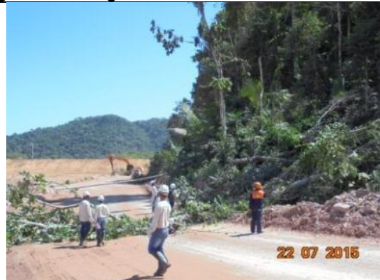
Figura 84: Acompanhamento da supressão durante o 12º mês do Programa de Resgate e Salvamento Científico da Fauna na área de instalação do canteiro de obras da UHE São Manoel.
