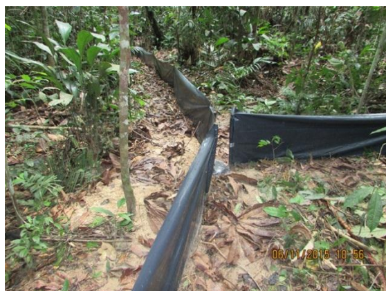
Figura 25: Armadilhas de interceptação e queda para o monitoramento das áreas de soltura durante o 16º mês do Programa de Resgate e Salvamento Científico da Fauna na área de instalação do canteiro de obras da UHE São Manoel.
