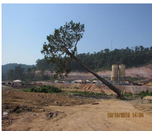
Figura 16: Acompanhamento das atividades de supressão vegetal manual no canteiro durante o 15º mês do Programa de Resgate e Salvamento Científico da Fauna na área de instalação do canteiro de obras da UHE São Manoel.
