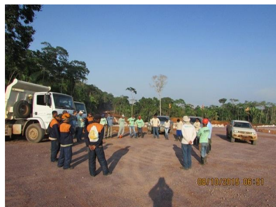
Figura 5: Diálogo Diário de Segurança realizado antes do início das atividades de supressão vegetal na área do canteiro de obras da UHE São Manoel.
