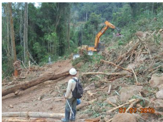
Figura 14: Acompanhamento da separação de toras e refugo vegetal durante o 13º mês do Programa de Resgate e Salvamento Científico da Fauna na área de instalação do canteiro de obras da UHE São Manoel.
