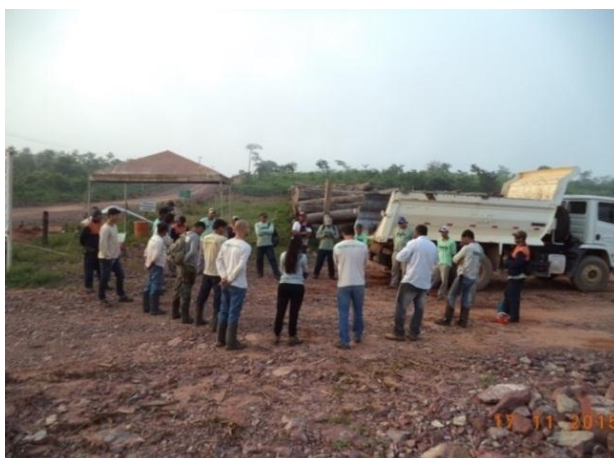
Figura 6: Diálogo Diário de Segurança realizado antes do início das atividades de supressão vegetal na área do canteiro de obras da UHE São Manoel.
