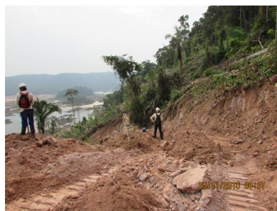
Figura 17: Acompanhamento de supressão vegetal mecanizada no acesso principal durante o 16º mês do Programa de Resgate e Salvamento Científico da Fauna na área de instalação do canteiro de obras da UHE São Manoel.
