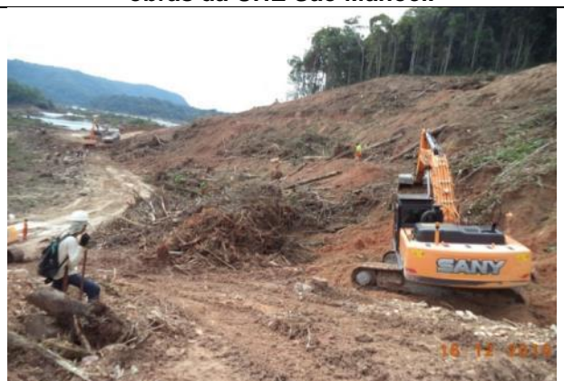
Figura 292: Acompanhamento das atividades de supressão na margem esquerda durante o 17º mês do Programa de Resgate de Germoplasma Vegetal na área de supressão vegetal para instalação do canteiro de obras da UHE São Manoel.
