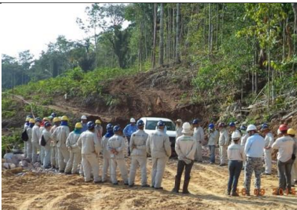
Figura 51: DDS realizada com a equipe da Arqueologia e Equipe da São Manoel Energia durante o 14º mês do Programa de Resgate de Germoplasma Vegetal na área de supressão vegetal para instalação do canteiro de obras da UHE São Manoel.
