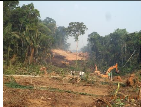
Figura 66: Equipe de Resgate de Germoplasma acompanhando as atividades de limpeza da área durante o 14º mês do Programa de Resgate de Germoplasma Vegetal na área de supressão vegetal para instalação do canteiro de obras da UHE São Manoel.
