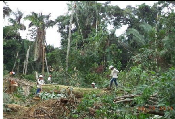
Figura 102: Resgate de germoplasma em área suprimida durante o 15º mês do Programa de Resgate de Germoplasma Vegetal na área de supressão vegetal para instalação do canteiro de obras da UHE São Manoel.
