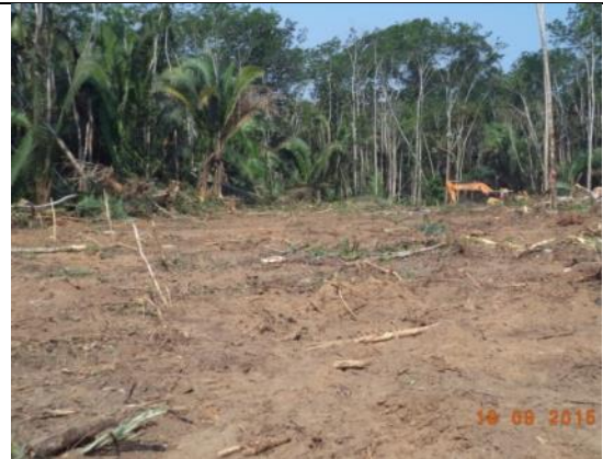
Figura 58: Acompanhamento das atividades de limpeza no acesso definitivo durante o 14º mês do Programa de Resgate de Germoplasma Vegetal na área de supressão vegetal para instalação do canteiro de obras da UHE São Manoel.
