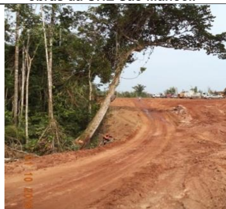
Figura 92: Acompanhamento de derrubada de árvore durante o 15º mês do Programa de Resgate de Germoplasma Vegetal na área de supressão vegetal para instalação do canteiro de obras da UHE São Manoel.
