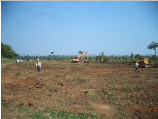
Figura 117: Acompanhamento da frente de supressão no Acesso definitivo durante o 15º mês do Programa de Resgate de Germoplasma Vegetal na área de supressão vegetal para instalação do canteiro de obras da UHE São Manoel.
