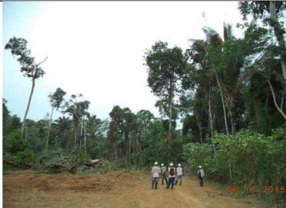
Figura 101: Acompanhamento das atividades de supressão no acesso definitivo durante o 15º mês do Programa de Resgate de Germoplasma Vegetal na área de supressão vegetal para instalação do canteiro de obras da UHE São Manoel.
