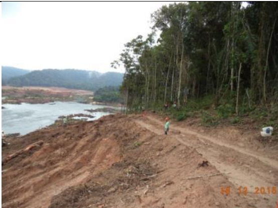
Figura 293: Acompanhamento das atividades de supressão na margem esquerda durante o 17º mês do Programa de Resgate de Germoplasma Vegetal na área de supressão vegetal para instalação do canteiro de obras da UHE São Manoel.
