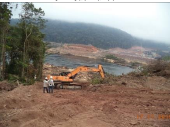
Figura 194: Equipe de Resgate de Germoplasma acompanhando as atividades de supressão na margem esquerda do rio durante o 16º mês do Programa de Resgate de Germoplasma Vegetal na área de supressão vegetal para instalação do canteiro de obras da UHE São Manoel.
