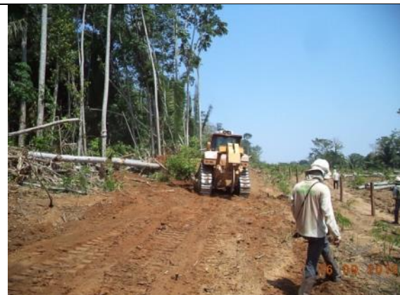
Figura 52: Acompanhamento da frente de supressão no acesso definitivo durante o 14º mês do Programa de Resgate de Germoplasma Vegetal na área de supressão vegetal para instalação do canteiro de obras da UHE São Manoel.
