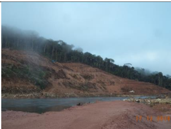
Figura 295: Vista geral da margem esquerda durante o 17º mês do Programa de Resgate de Germoplasma Vegetal na área de supressão vegetal para instalação do canteiro de obras da UHE São Manoel.
