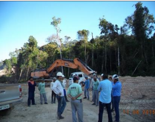
Figura 9: DDS realizada com a Equipe da OMS durante o 13º mês do Programa de Resgate de Germoplasma Vegetal na área de supressão vegetal para instalação do canteiro de obras da UHE São Manoel.
