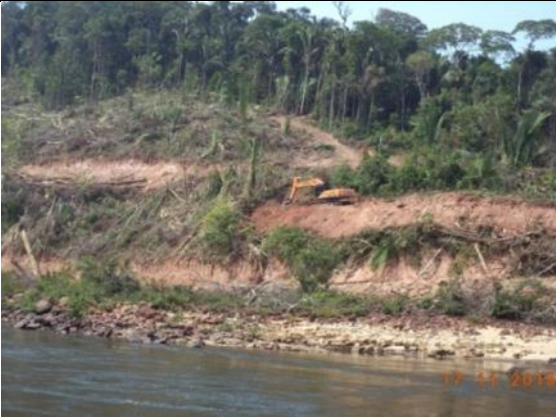
Figura 195: Vista geral da margem esquerda em supressão durante o 16º mês do Programa de Resgate de Germoplasma Vegetal na área de supressão vegetal para instalação do canteiro de obras da UHE São Manoel.
