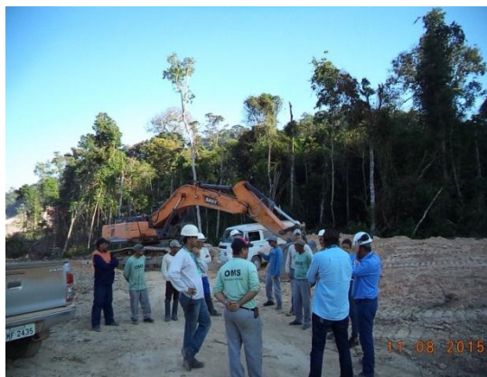
Figura 4: DDS realizada com a Equipe da OMS durante o 13º mês do Programa de Resgate de Germoplasma Vegetal na área de supressão vegetal para instalação do canteiro de obras da UHE São Manoel.
