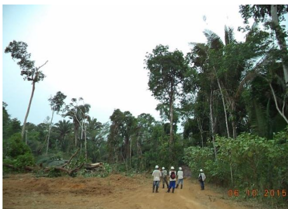
Figura 8: Acompanhamento das atividades de supressão no acesso definitivo durante o 15º mês do Programa de Resgate de Germoplasma Vegetal na área de supressão vegetal para instalação do canteiro de obras da UHE São Manoel.
