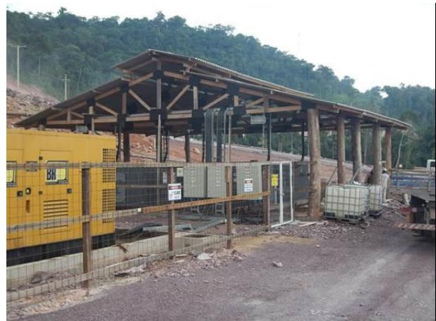
Figura 38: Galpão de abrigo da central de ar comprimido.
