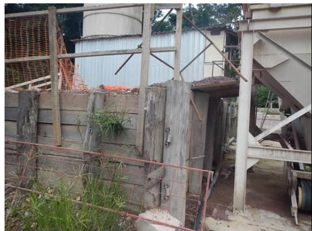
Figura 40: Muro de arrimo da central de concreto provisória.
