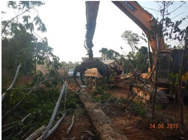
Figura 15: Vista da destoca e limpeza do terreno.
