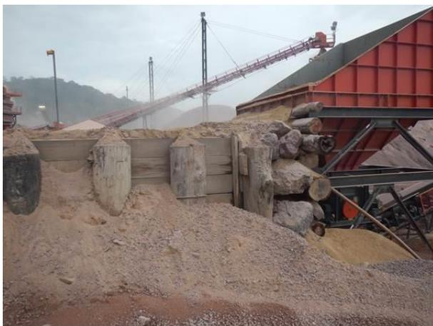
Figura 39: Muro de arrimo da rampa de acesso da central de concreto.
