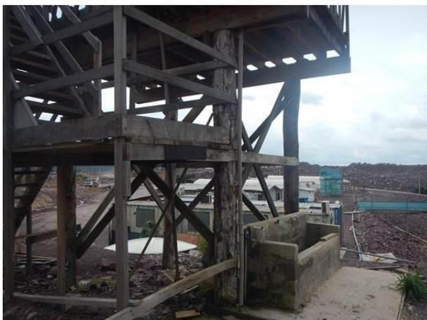
Figura 35: Estrutura de suporte da caixa d'água da região da tomada d'água.
