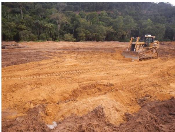
Figura 34: Compactação da área da vala e nivelamento do terreno.
