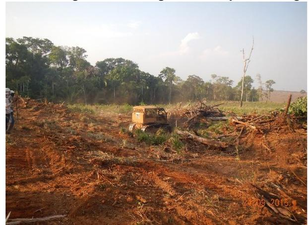
Figura 16: Vista da destoca e limpeza do terreno.
