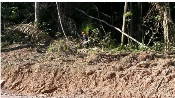
Figura 9: Vista da limpeza do sub-bosque com o uso do motosserra.
