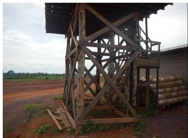
Figura 42: Estrutura da caixa d'água da da central de gerenciamento de resíduos.
