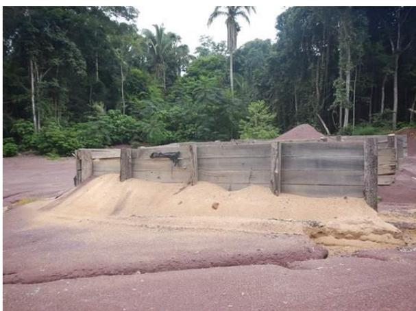
Figura 41: Baias de armazenamento de areia e brita da central de concreto provisória.
