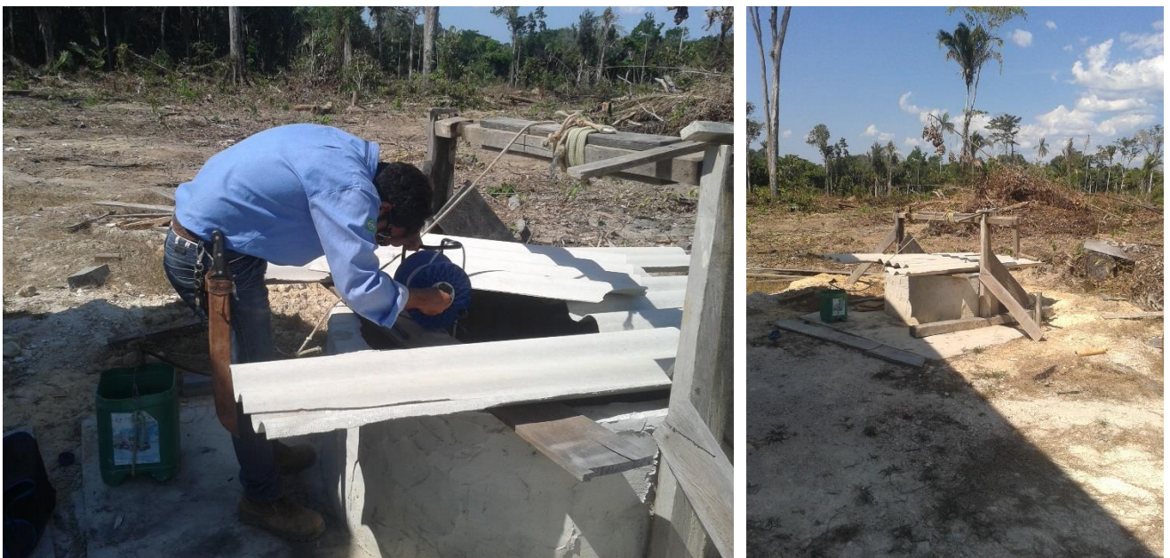
Figura 4.26. Cisterna catalogada na campanha de agosto de 2015.
