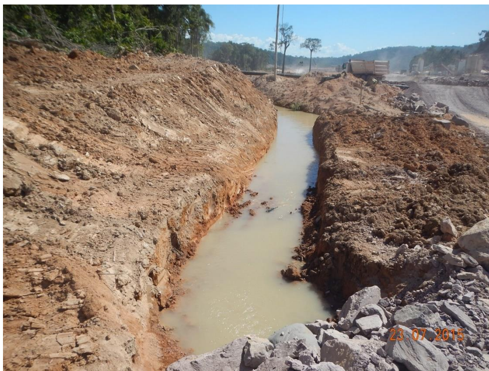
Figura 4: Vista geral do canal do vale e do canal de escoamento por gravidade até o rio Teles Pires.
