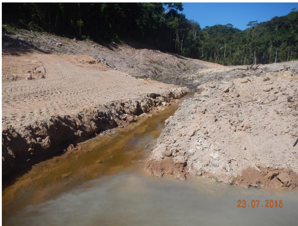
Figura 3: Vista geral do canal do vale e do canal de escoamento por gravidade até o rio Teles Pires.
