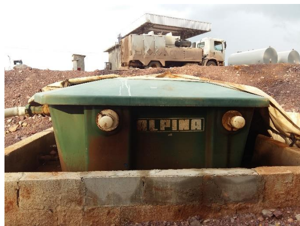
Figura 3.3-20: Caixa separadora de água e óleo com elemento filtrante.
