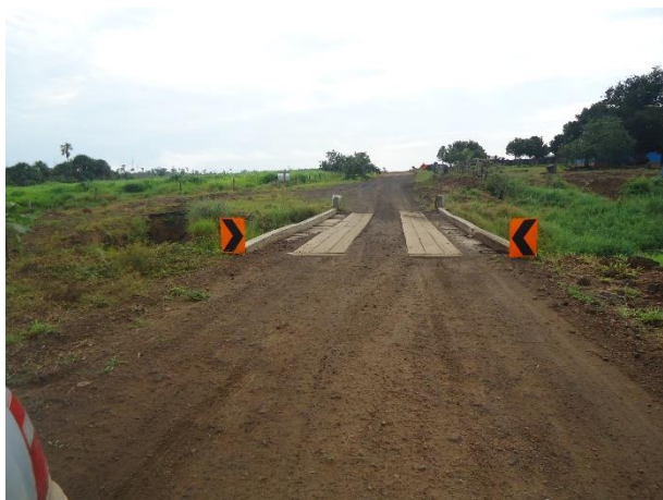
Figura 3.3-1: Vista da ponte recuperada.
