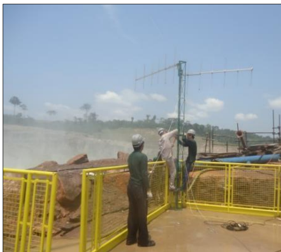
Figura 3.24-1: Fixação do módulo superior e preparação do cabo de aço para fixação na Estação 01, na UHE Teles Pires. Fonte: BIOLEX, 2015.
