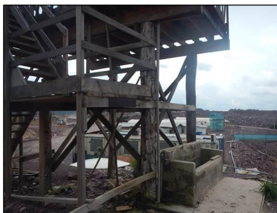
Figura 3.13-4: Estrutura interna construída com madeira proveniente da ASV 936/2014. Fonte: Constran/UTC, 2015.
