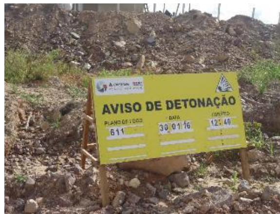
Figura 3.3.4-4: Sinalização de detonação.
