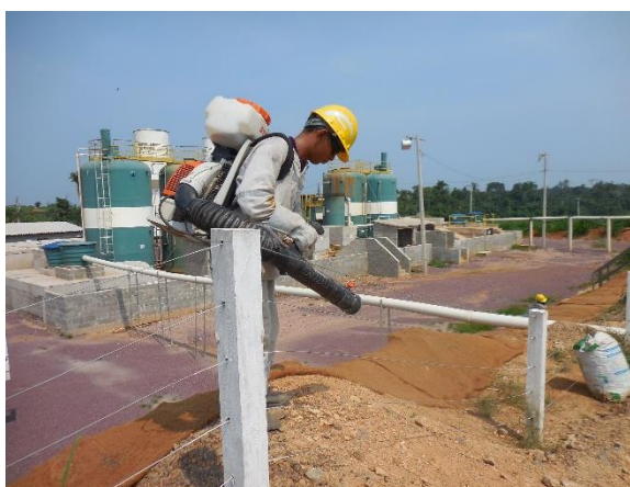
Figura 3.3.3-1: Plantio de sementes de Brachiaria decumbens após aplicação de biomanta.
