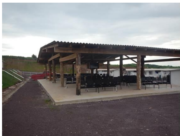
Figura 3.3-5: Sala de televisão entre os blocos de alojamento e taludes com revestimento vegetal.
