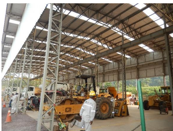
Figura 3.3-17: Oficina mecânica definitiva. Detalhe do teto que aproveita a luz solar.
