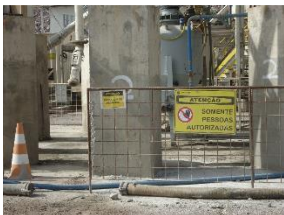
Figura 3.3.4-1: Sinalização e isolamento em área de trabalho.
