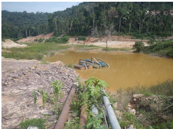
Figura 3.3-21: Lagoa e tubulação de recalque.
