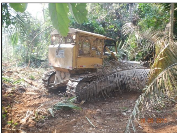
Figura 3.13-1: Limpeza de sub-bosque com trator esteira. Fonte: Constran/UTC, 2015.
