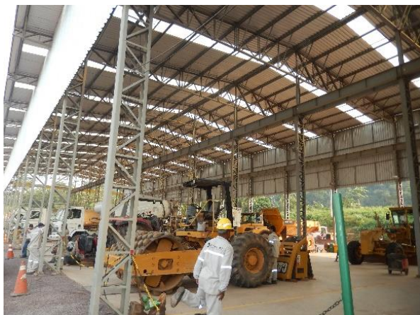
Figura 3.3-13: Oficina de manutenção concluída e operando.
