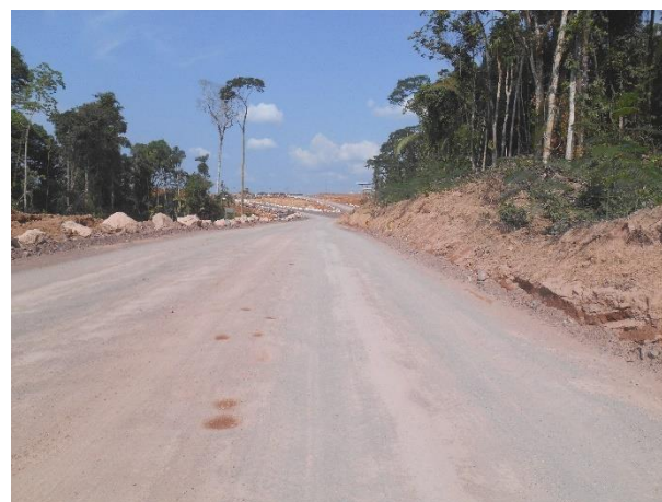
Figura 3.3-4: Acesso à área industrial em boas condições de manutenção.
