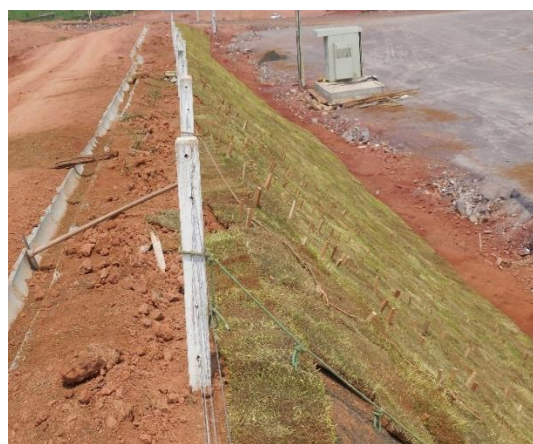
Figura 3.3.3-2: Plantio de placas de grama no talude do refeitório.
