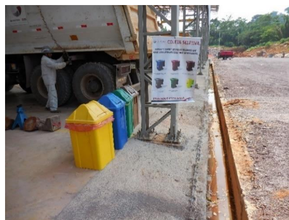
Figura 3.3-18: Canaleta coletora com drenagem para a caixa SAO.
