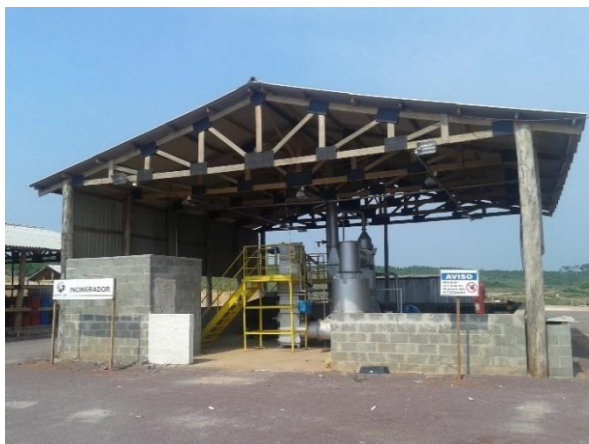
Figura 3.3.2-3: Galpão do incinerador.
