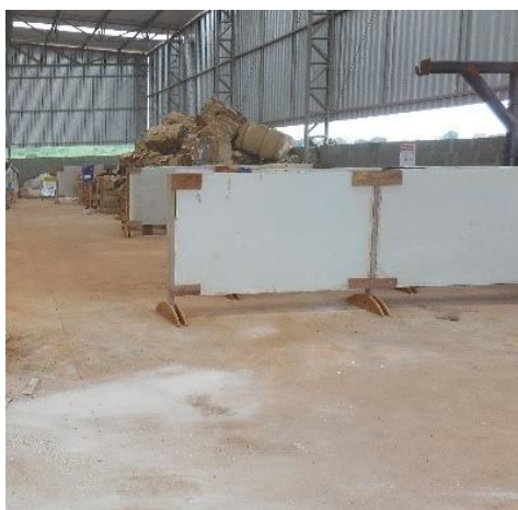
Figura 3.3.2-1: Galpão de triagem de resíduos.
