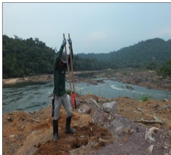
Figura 3.24-2: Escavação da fundação da torre da Estação 02. Fonte: BIOLEX, 2015.
