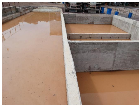
Figura 3.3-14: Tanques de decantação do sistema de controle de efluentes da rampa de lavagem.
