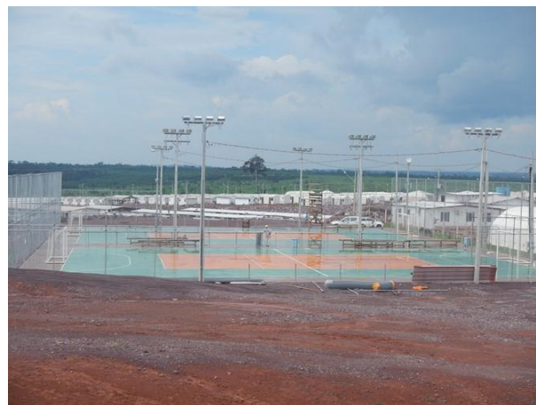
Figura 3.3-8: Quadras poliesportivas concluídas.
