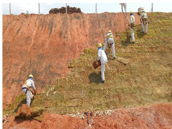
Figura 3.3.3-6: Composto sendo utilizado na recuperação de taludes.
