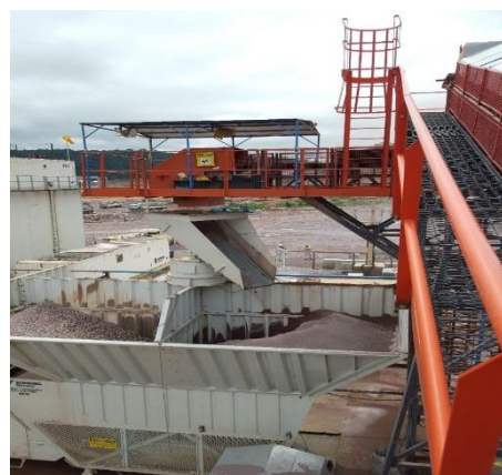
Figura 3.3-10: Central de concreto em funcionamento.
