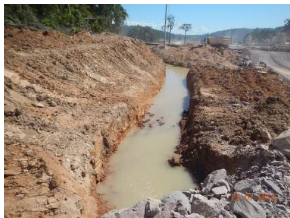
Figura 3.3-22: Canal de escoamento por gravidade até o rio Teles Pires.
