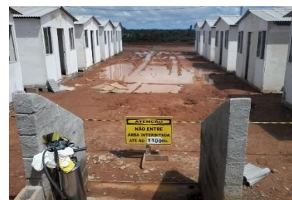
Aplicação de Borrifação Residual nos alojamentos em 18/02/2015.
