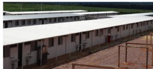
Alojamento definitivo - Construção do primeiro condomínio dos alojamentos definitivos do canteiro de obras da UHE São Manoel.
