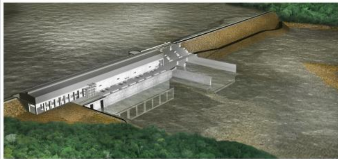
Layout gráfico em 3D do barramento/reservatório da UHE São Manoel
