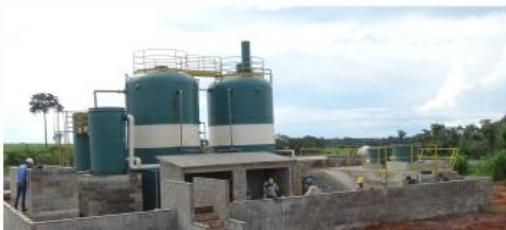
ETE - Execução da Estação de Tratamento de Esgoto, responsável por tratar todo esgoto gerado pela UHE São Manoel.
