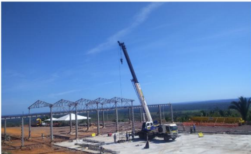
Continuação na montagem do Pátio de Armação
