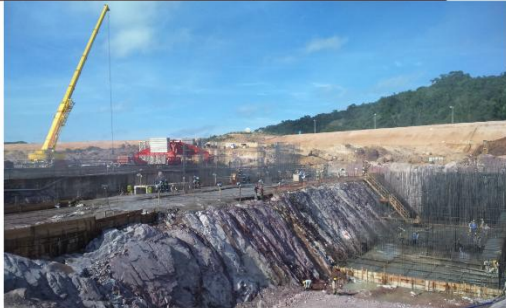
Início da concretagem do Bloco 02 do vertedouro
