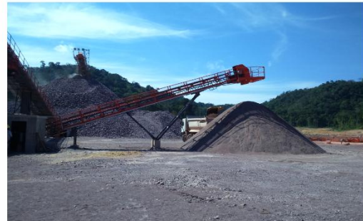
Início da operação do britador primário
