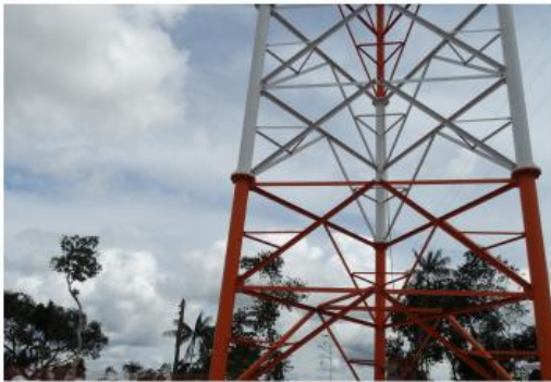
Torre de Transmissão - Início da instalação da torre de comunicação do canteiro de obras.
