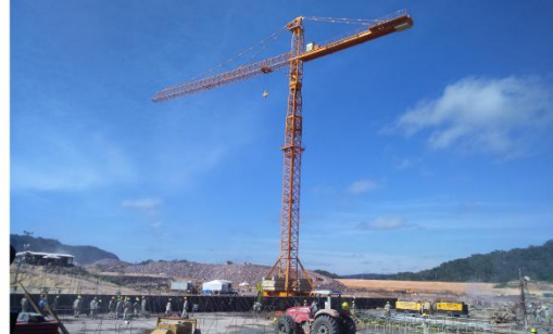
Montagem da Grua na Área de Montagem
