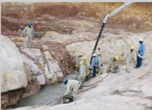
Concretagem representa início das obras civis da UHE São Manoel
