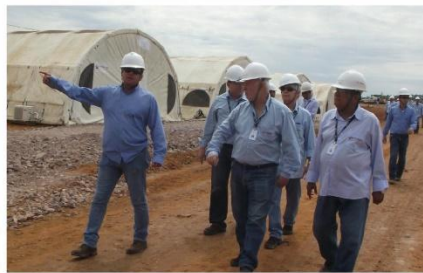
Diretor do Projeto apresenta canteiro de obras para engenheiros da Empresa de Energia São Manoel
