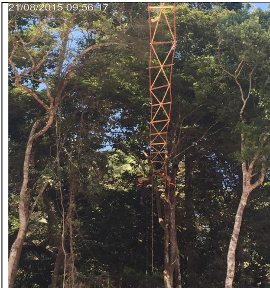
Figura 05: Passagem aérea já em fase de fixação aos pontos aéreos.
