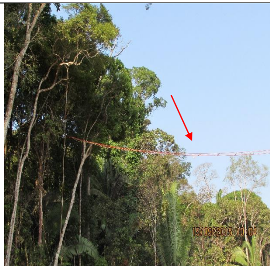
Figura 08: Vista de deslocamento da passagem já fixada, contemplando 54m de comprimento, ligando as duas extremidades do acesso interno.
