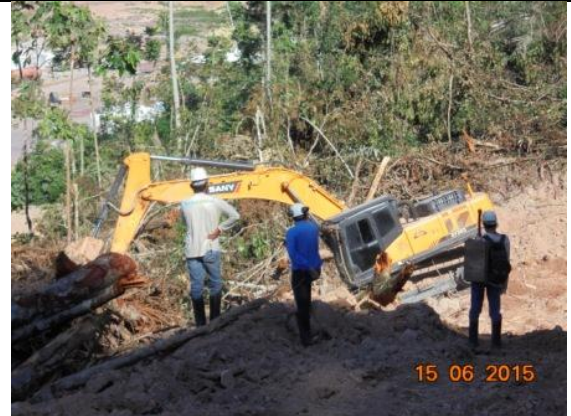
Figura 449: Acompanhamento das atividades de abertura de acesso, separação de toras e enterro de refugo vegetal durante o 11º mês do Programa de Resgate e Salvamento Científico da Fauna na área de supressão vegetal para instalação do canteiro de obras da UHE São Manoel.
