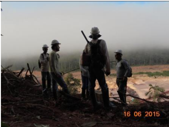
Figura 450: DDS e alinhamento de trabalho entre integrantes da equipe durante o 11º mês do Programa de Resgate e Salvamento Científico da Fauna na área de supressão vegetal para instalação do canteiro de obras da UHE São Manoel.
