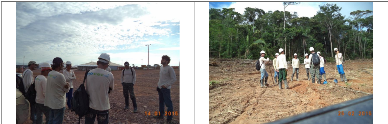
Figura 4: Realização de DDS diária durante o 6º mês do Programa de Resgate de Germoplasma Vegetal na área de supressão vegetal para instalação do canteiro de obras da UHE São Manoel.
