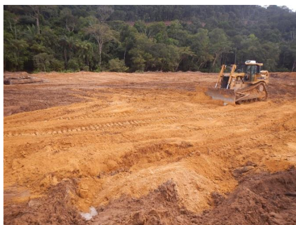
Figura 34: Compactação da área da vala e nivelamento do terreno.
