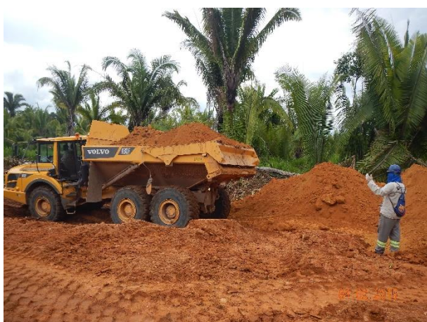
Figura 33: Deposição de argila na superfície da vala para compactação.
