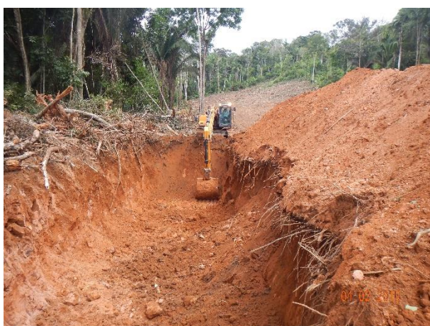
Figura 31: Vista da vala de enterrio de resíduos de madeira.
