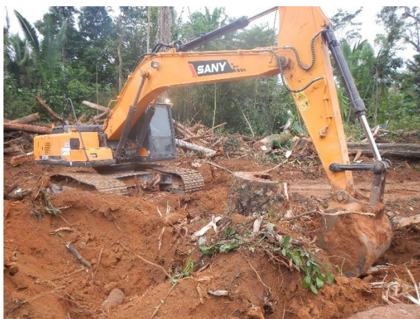
Figura 15: Vista da destoca e limpeza do terreno.
