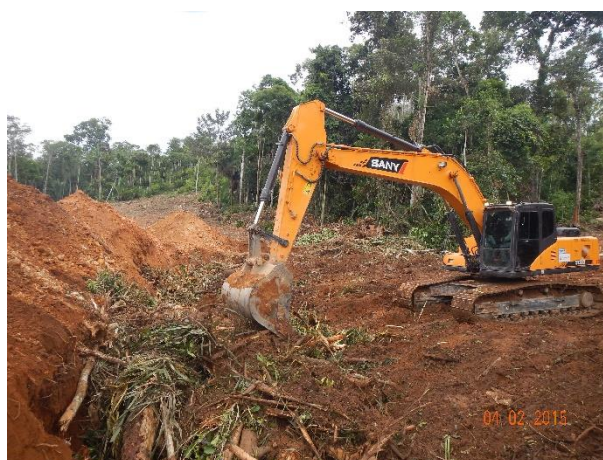
Figura 32: Deposição dos resíduos na vala.
