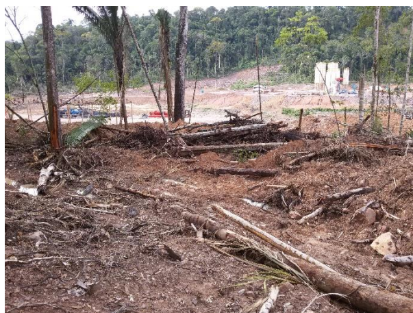
Figura 10: Vista da limpeza do sub-bosque com o uso do trator de esteira.
