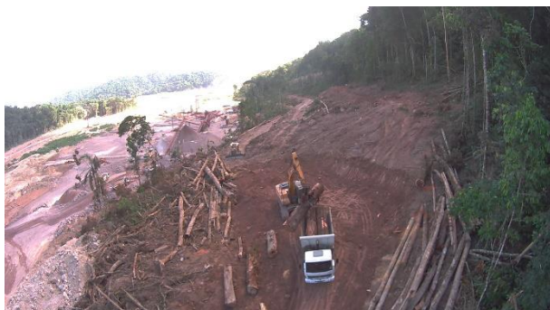
Figura 19: Vista do carregamento das toras da região da região do britador.
