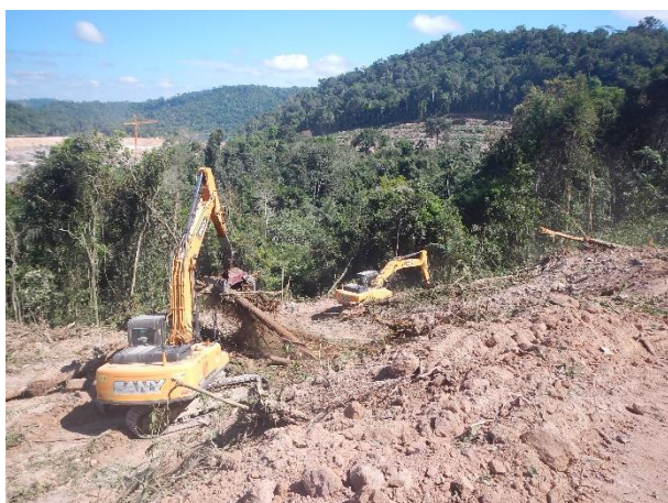
Figura 17: Vista do enleiramento dos resíduos.
