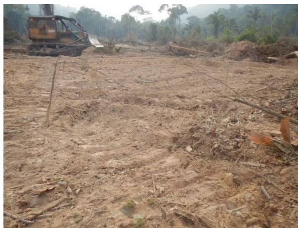
Figura 16: Vista da destoca e limpeza do terreno.
