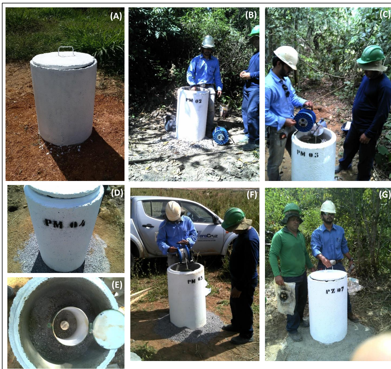
Figura 8. Fotos dos piezômetros perfurados. (A) PM-01; (B) PM-02; (C) PM-03; (D) PM-04; (E) PZ-06; (F) PM-05; (G) PZ-07.
