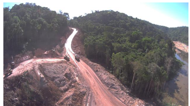
Figura 140: Vista geral das atividades de estabilização dos taludes nos acessos construídos.
