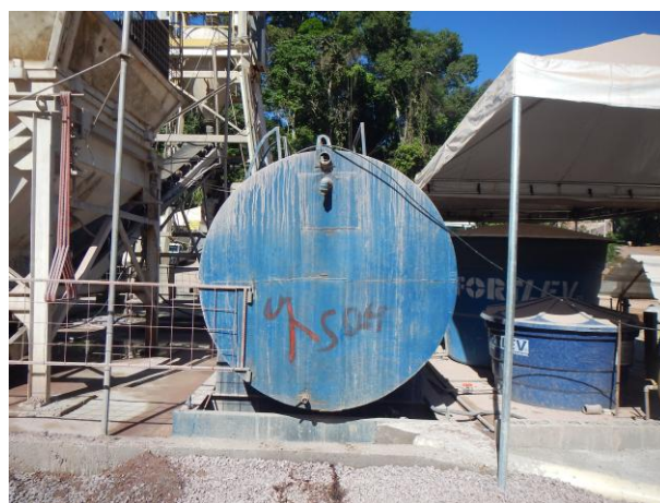
Figura 64: Vista do tanque de água industrial da central provisória de concreto.
