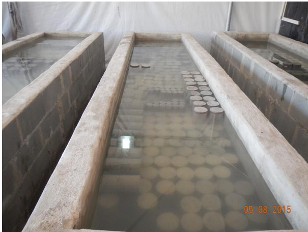
Figura 67: Vista do tanque de saturação.
