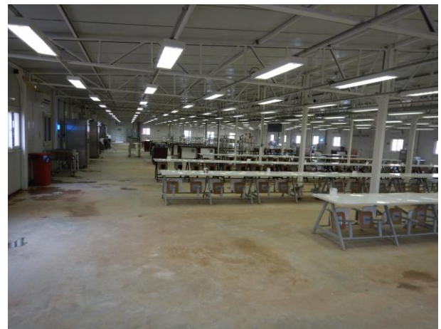
Figura 22: Vista geral do refeitório.
