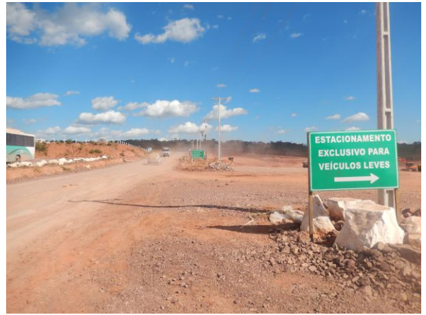
Figura 13: Vista geral do acesso principal dos alojamentos para a área industrial.
