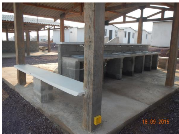
Figura 50: Vista geral da lavanderia.
