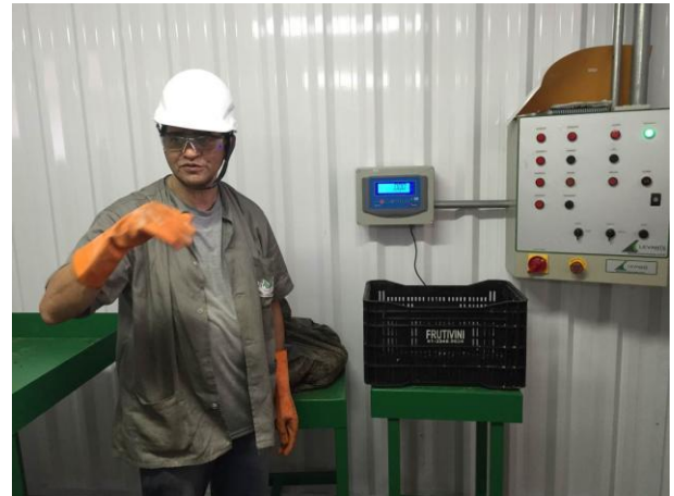
Figura 132: Vista do painel de controle do equipamento.
