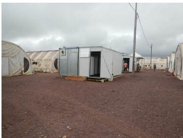
Figura 37: Vista dos banheiros coletivos.
