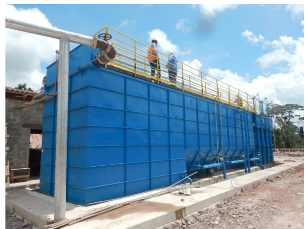
Figura 97: Vista geral da ETA.
