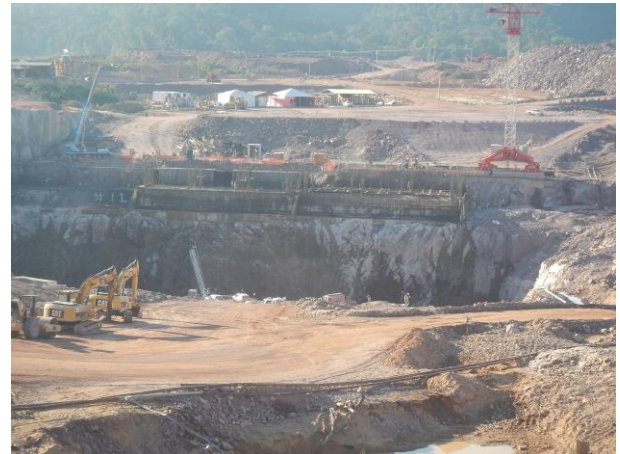
Figura 223: Vista geral da área de construção da casa de força.
