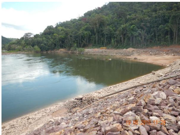
Figura 92: Vista geral da área de captação de água para abastecimento público da UHE São Manoel.
