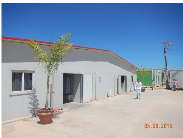
Figura 52: Vista do escritório do Consórcio Constran-UTC São Manoel.
