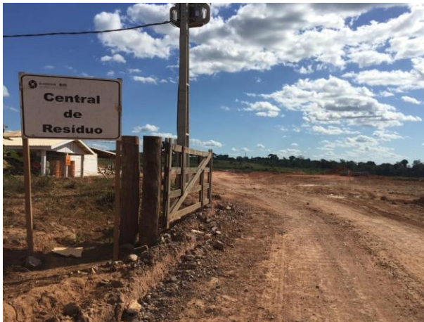
Figura 117: Central de coleta e triagem de resíduos.
