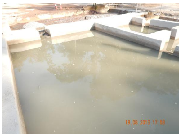
Figura 65: Vista da limpeza de um caminhão betoneira.
