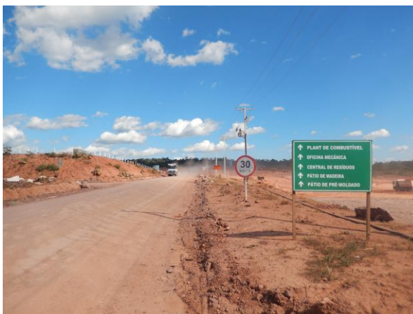
Figura 14: Vista geral do acesso principal dos alojamentos para a área industrial.
