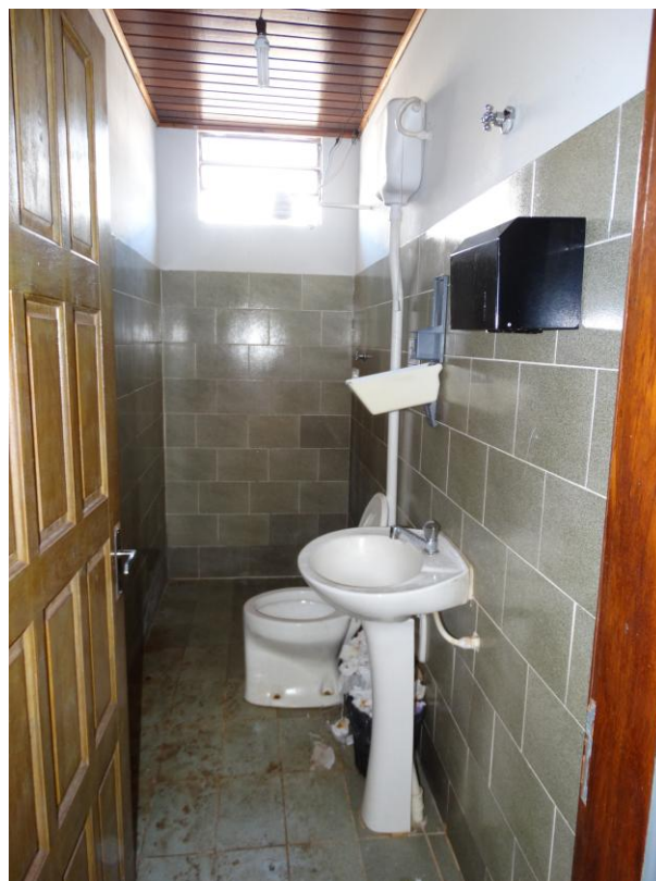
Figura 427: Vista do banheiro em frente ao banco Caixa Econômica Federal do município de Paranaíta – MT disponibilizado aos trabalhadores com manutenção e abastecimento contínuo.
