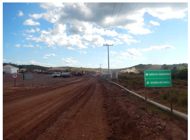
Figura 15: Vista geral do acesso para a área industrial.
