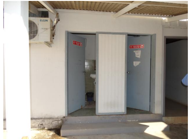
Figura 429: Vista do banheiro em frente ao banco Caixa Econômica Federal do município de Paranaíta – MT disponibilizado aos trabalhadores com manutenção e abastecimento contínuo.
