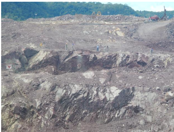
Figura 224: Vista geral da limpeza das rochas após o desmonte.
