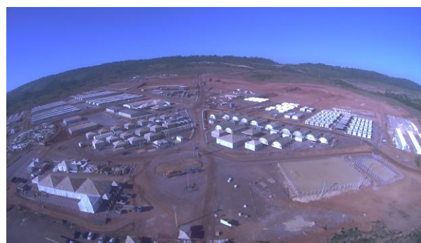
Figura 19: Vista geral do acampamento em julho de 2015.
