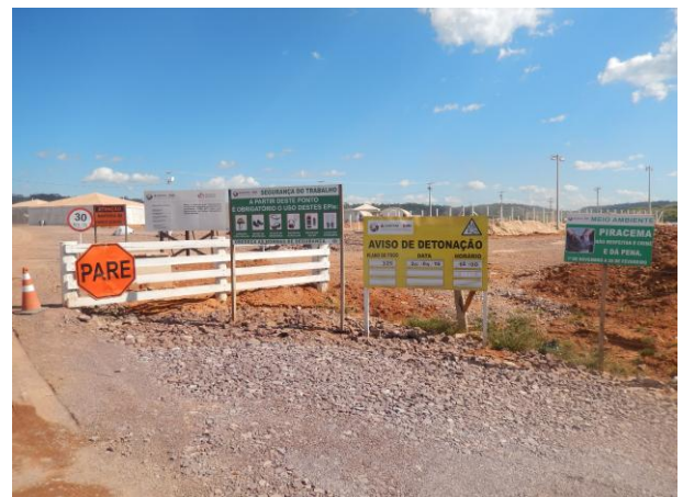
Figura 9: Vista da portaria provisória.
