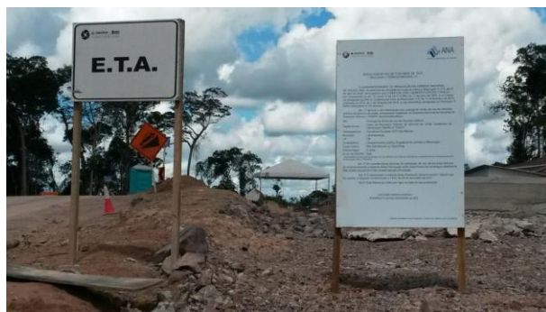
Figura 96: Vista geral da área de instalação da ETA.
