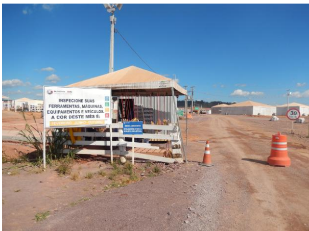
Figura 8: Vista geral da portaria provisória.
