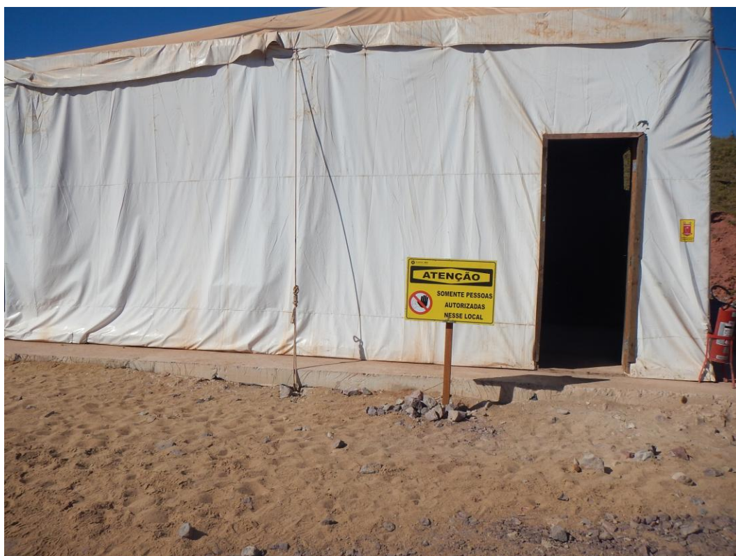
Figura 84: Vista do depósito da oficina mecânica provisória.
