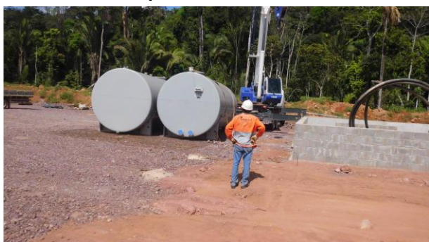
Figura 76: Vista do ponto de abastecimento definitivo.
