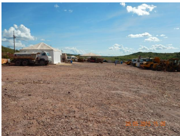
Figura 220: Vista geral da oficina mecânica provisória.
