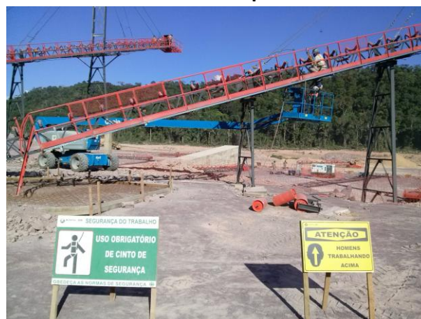
Figura 202: Trabalho em altura devidamente assegurado.
