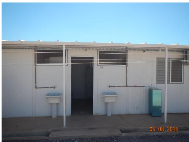
Figura 236: Vista da entrada dos alojamentos.
