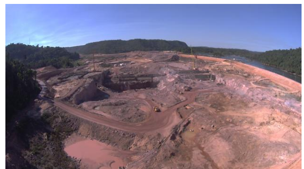
Figura 89: Vista frontal da área de construção da casa de força, unidades geradoras e vertedouros da UHE São Manoel.
