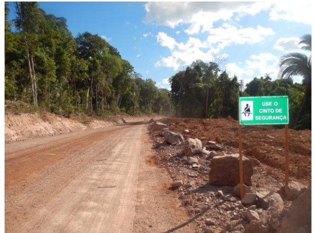
Figura 11: Vista geral do acesso à área industrial.
