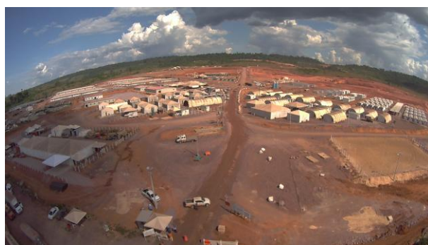
Figura 18: Vista geral do acampamento em maio de 2015.
