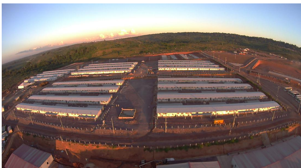
Figura 20: Vista geral dos blocos de alojamentos construídos.
