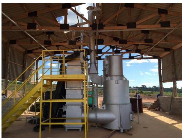
Figura 115: Incinerador em fase final de construção no canteiro de obras da UHE São Manoel.
