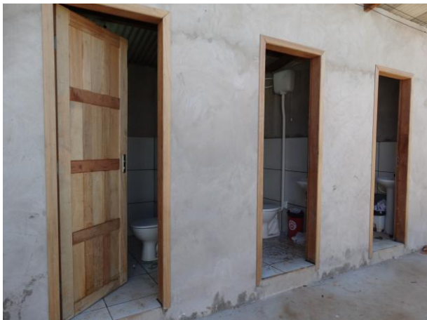
Figura 430: Vista do banheiro em frente ao banco Caixa Econômica Federal do município de Paranaíta – MT disponibilizado aos trabalhadores com manutenção e abastecimento contínuo.
