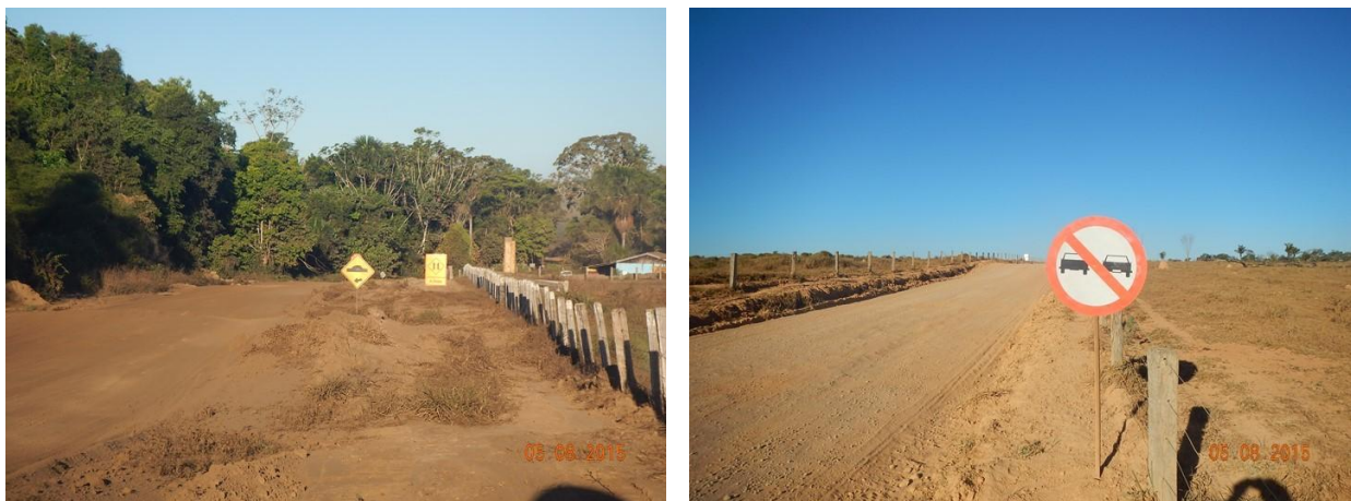
Figura 6: Vista da sinalização de obstáculos e proibição de ultrapassagem.
