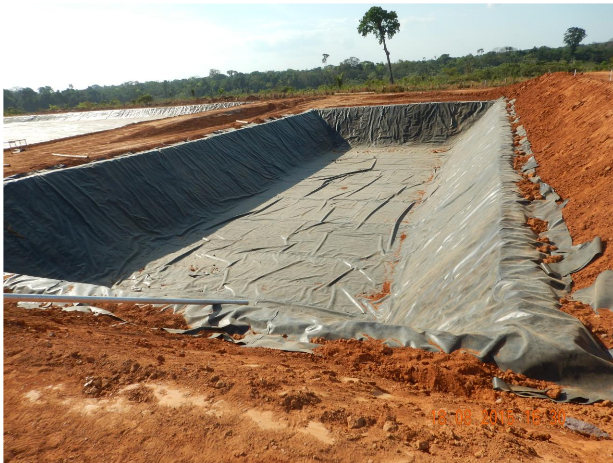
Figura 105: Vista geral da lagoa facultativa.
