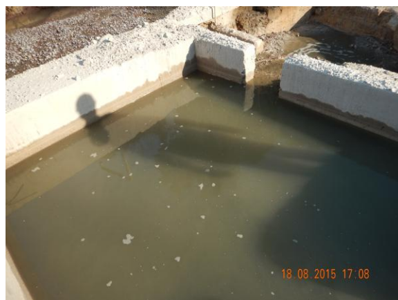
Figura 66: Vista do bate lastro.
