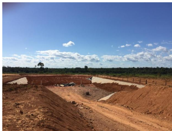
Figura 113: Aterro sanitário da UHE São Manoel.
