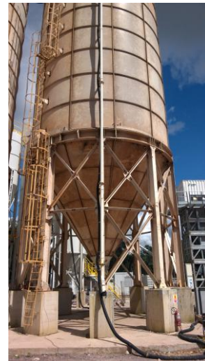
Figura 58: Vista do silo de armazenamento de cimento.
