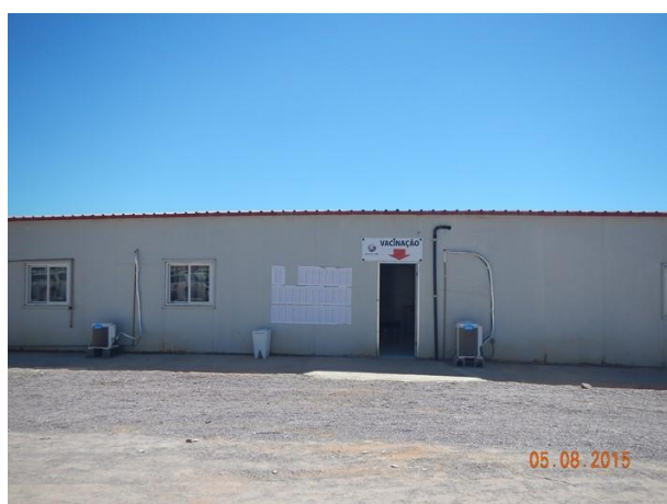
Figura 33: Vista geral da entrada do ambulatório definitivo.
