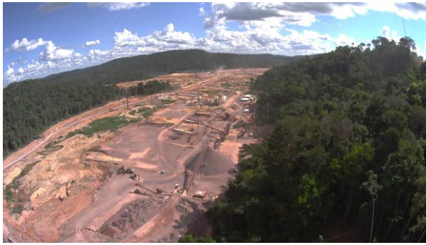
Figura 57: Vista superior da central de britagem e da central de concreto ao fundo.
