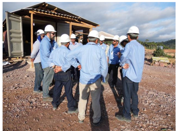
Figura 196: Reunião de Segurança com Encarregados e Engenheiros na Área de Montagem.
