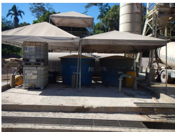
Figura 63: Vista geral da central de concreto provisória.
