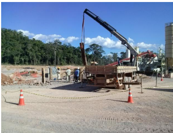
Figura 195: Sinalização da área isolada para levantamento de carga com caminhão Munck .
