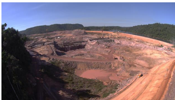
Figura 88: Vista frontal da área de construção da casa de força, unidades geradoras e vertedouros da UHE São Manoel.
