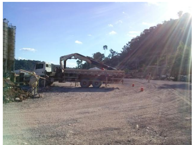
Figura 194: Sinalização da área isolada para levantamento de carga com caminhão Munck .
