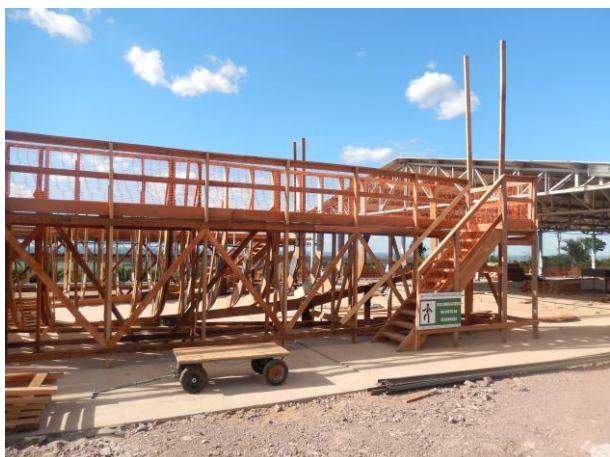
Figura 229: Escada com guarda corpo.
