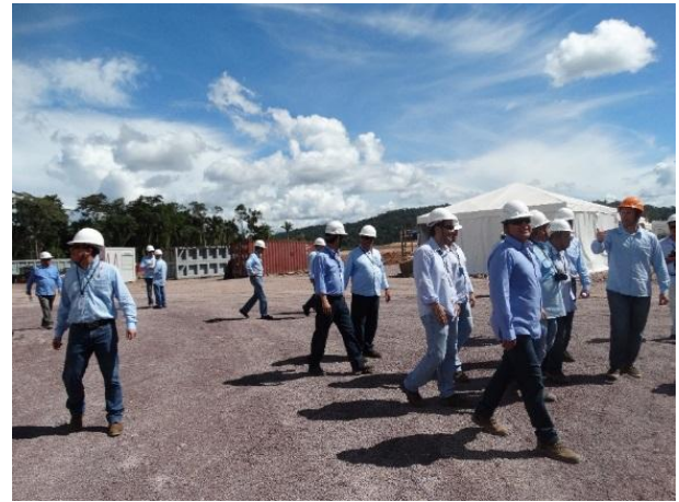
Figura 310: Visita técnica nas dependências do canteiro de obras.
