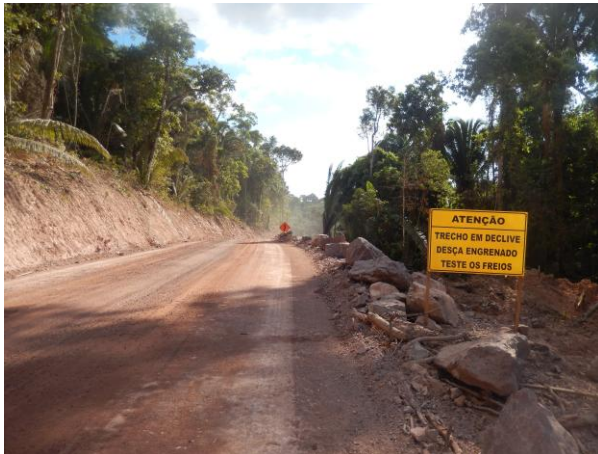
Figura 16: Vista geral do acesso em declive para a área industrial.
