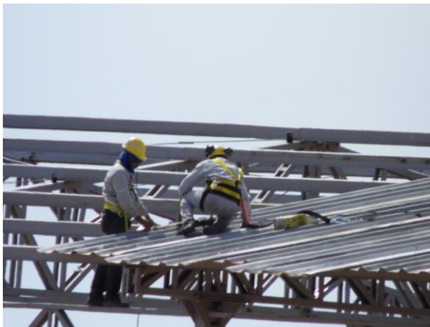
Figura 200: Trabalho em altura devidamente assegurado.
