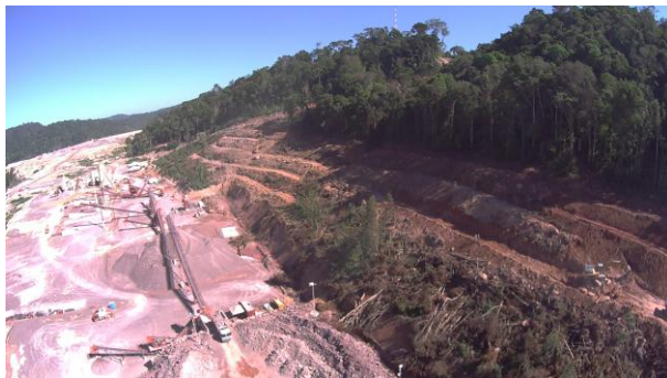
Figura 139: Vista geral das atividades de estabilização dos taludes da margem direita.
