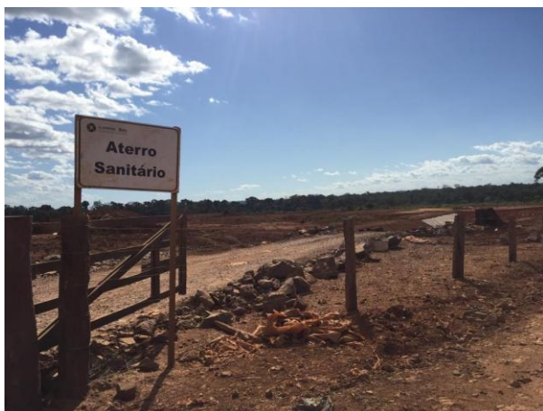
Figura 112: Aterro sanitário da UHE São Manoel.
