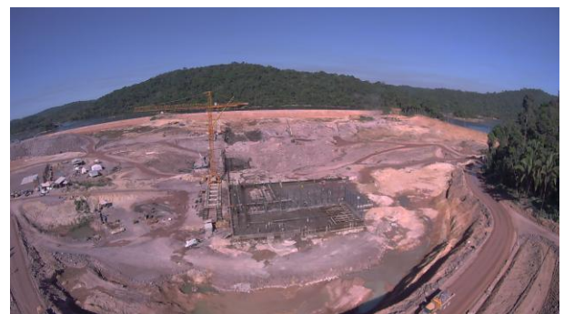
Figura 87: Vista lateral da área de construção da casa de força, unidades geradoras e vertedouros da UHE São Manoel.
