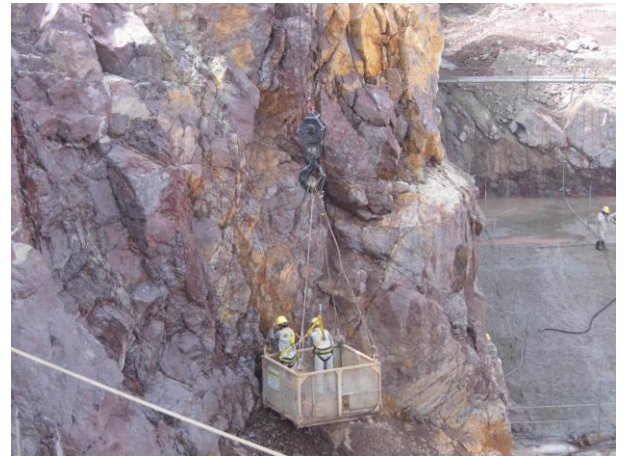
Figura 199: Trabalho em altura devidamente assegurado.
