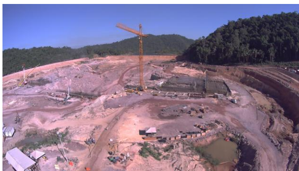
Figura 86: Vista da área de construção da casa de força, unidades geradoras e vertedouros da UHE São Manoel.
