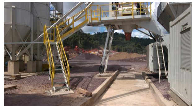
Figura 62: Vista do carregador de concreto.
