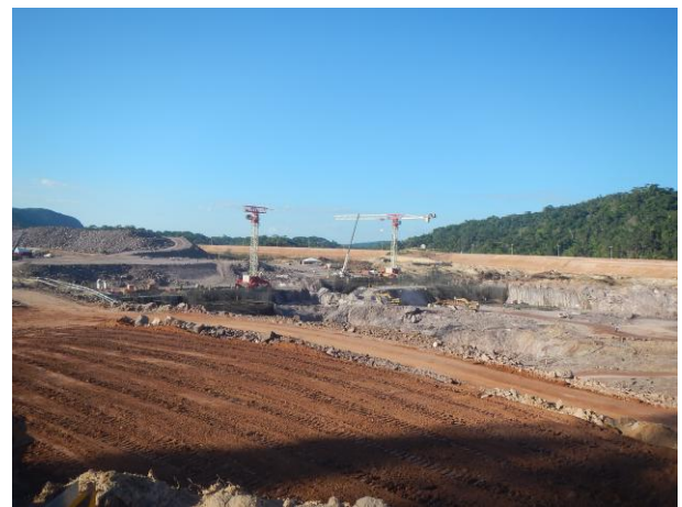
Figura 225: Vista geral da área de escavação e construção das estruturas da barragem.
