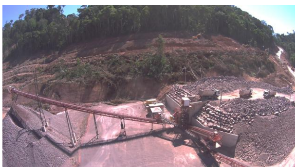
Figura 55: Vista superior do britador.
