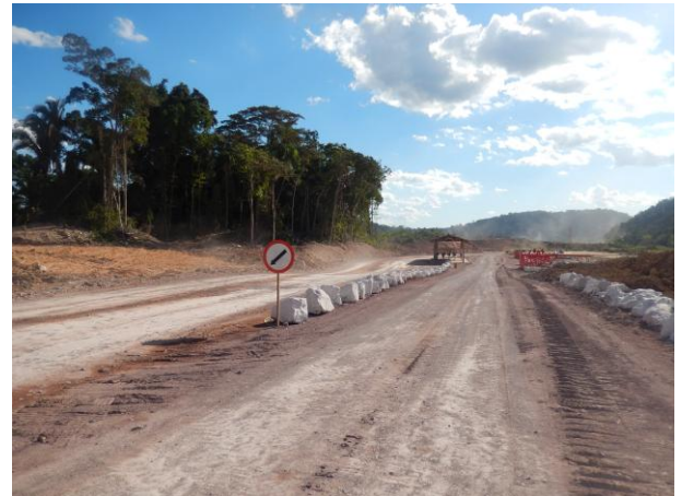
Figura 17: Vista geral do acesso na área industrial.
