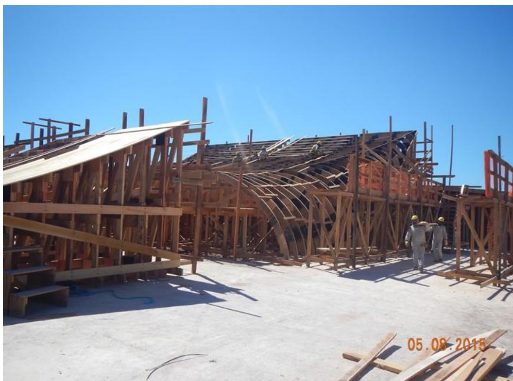
Figura 73: Vista da área de montagem de formas.
