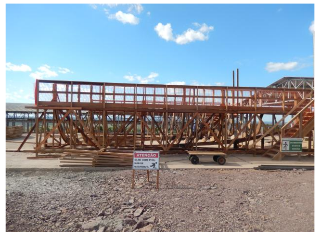
Figura 228: Escada com guarda corpo.
