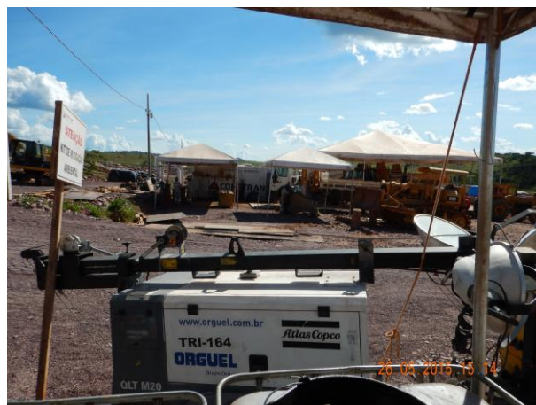
Figura 221: Vista geral da oficina mecânica provisória.
