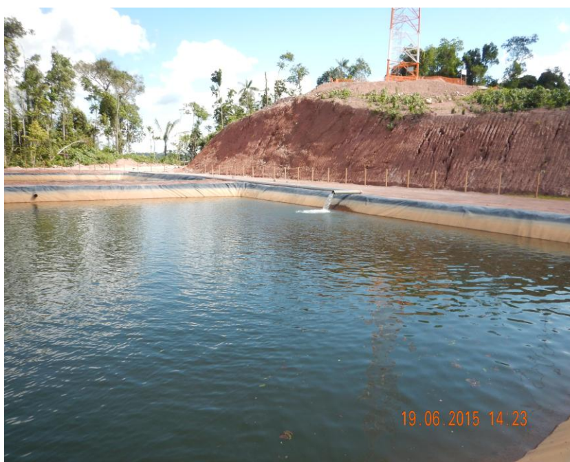
Figura 94: Vista geral do abastecimento dos reservatórios de água bruta.
