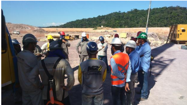
Figura 198: Reunião sobre análise preliminar de riscos da montagem da grua.
