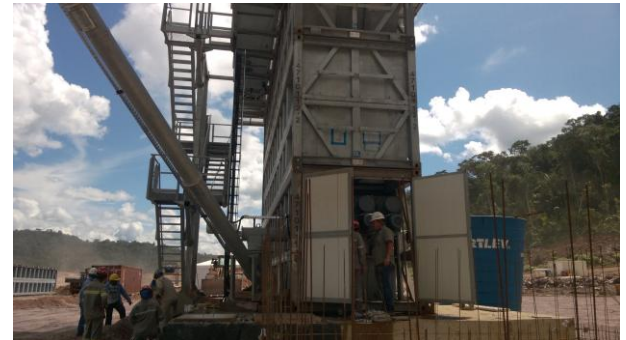
Figura 60: Vista da fábrica de gelo para concreto.
