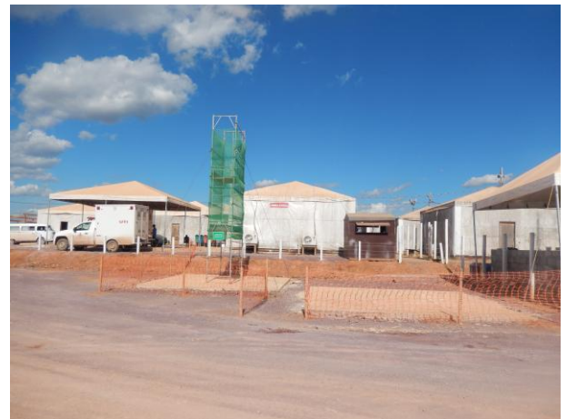
Figura 201: Estrutura de andaimes utilizada para treinamentos em trabalho em altura.
