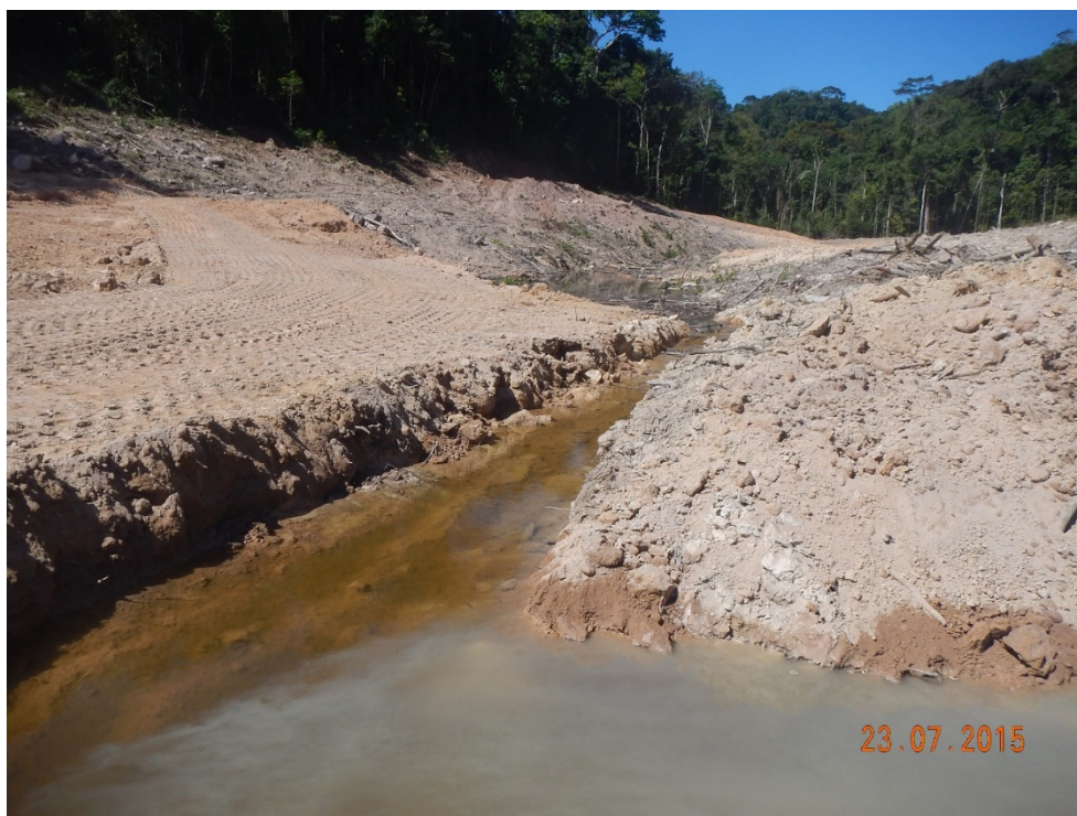
Figura 1: Vista geral do canal do vale e do canal de escoamento por gravidade até o rio Teles Pires.
