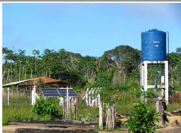
**Foto 48:** Caixa d'água da aldeia Mairowi. Destaque para placa solar que alimenta a bomba.
