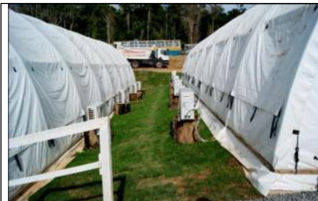
Figura 6: Alojamento no Canteiro Pioneiro com Proteção e telas de isolamento de vetores
