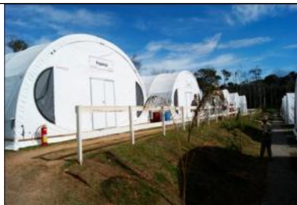
Figura 7: Alojamento no Canteiro Pioneiro com Proteção e telas de isolamento de vetores
