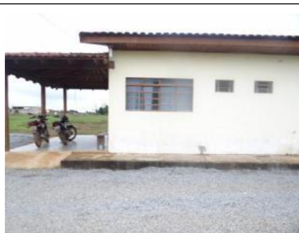
Figura 97: Laboratório Municipal onde será reformado de acordo com a pactuação.
