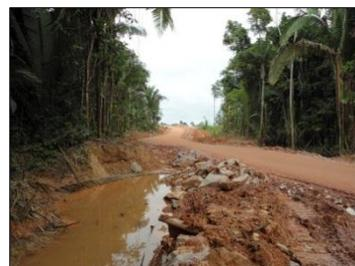
Criadouro provisório e com sujidade decorrente de terraplanagem
