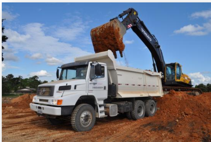
Figura 14 Módulo Técnico - Turma de Motorista de Caminhão Basculante interagindo com a Turma de Escavadeira
