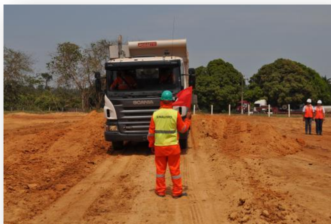
Figura 16 Módulo Técnico - Turma de Sinaleiro de Terraplanagem
