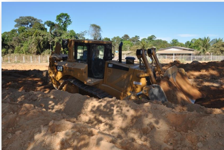
Figura 15 Módulo Técnico - Turma de Operador de Equipamentos (Trator de esteira)
