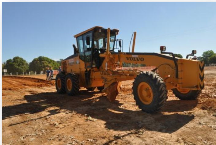
Figura 13 Módulo Técnico - Aulas de Operador de Equipamentos (Motoniveladora)
