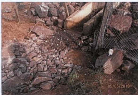
Foto 3 - Reduzido o desnível em uma das entradas da entrada da passagem de fauna 1.
