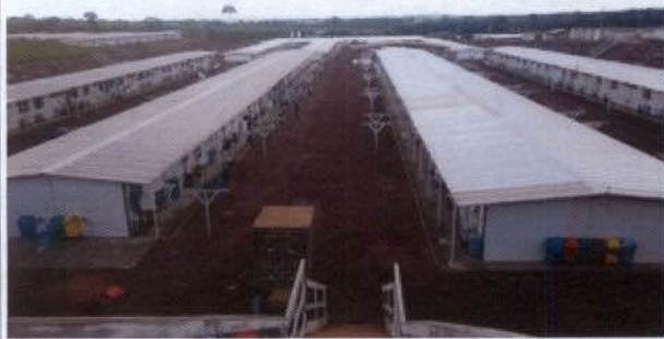
Fig. 43 – Alojamento no canteiro de obras
