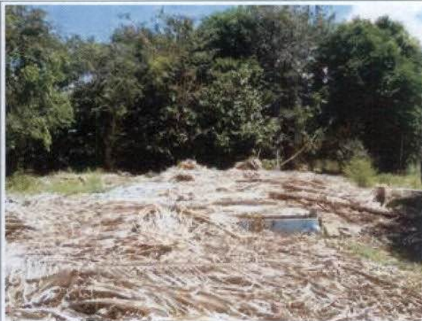
Fig. 68 – Ilha antes habitada pela D. Esther, restos da habitação que foi demolida (P13 e P14).
