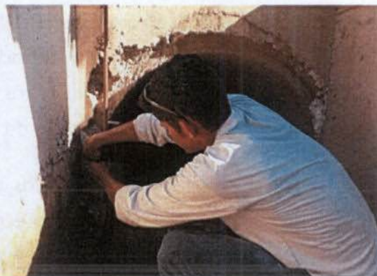
Foto 06 - Instalação da armadilha fotográfica na passagem de fauna no acesso A
