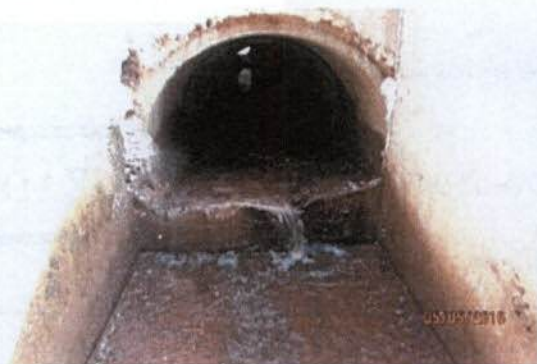
Foto 01- Retirado o volume de concreto que obstruíam parte da entrada da passagem de fauna 1.
