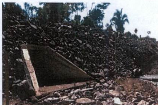
Foto 02- Retirado blocos de rochas que obstruíam a entrada da passagem de fauna 2.
