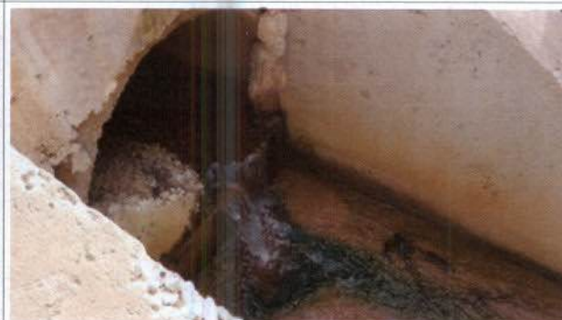
Fig. 116 – Pedacos de rochas bstruindo parcialmente a entrada da passagem de fauna.
