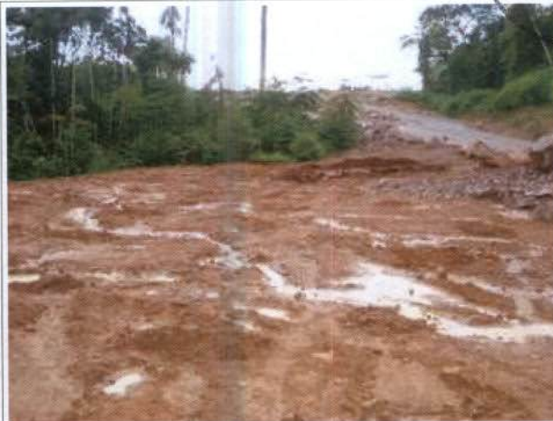
Fig. 74 – (MD) Jacareacanga/PA, PRAD na área do canteiro de obras (P17).
