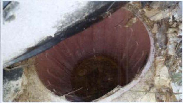
Fig. 124 – Acúmulo de água em um dos baldes das armadilhas de interceptação e queda.
