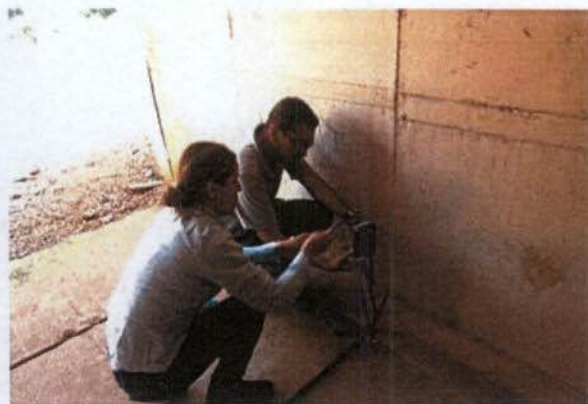
Foto 04 - Instalação da armadilha fotográfica na passagem de fauna no acesso A
