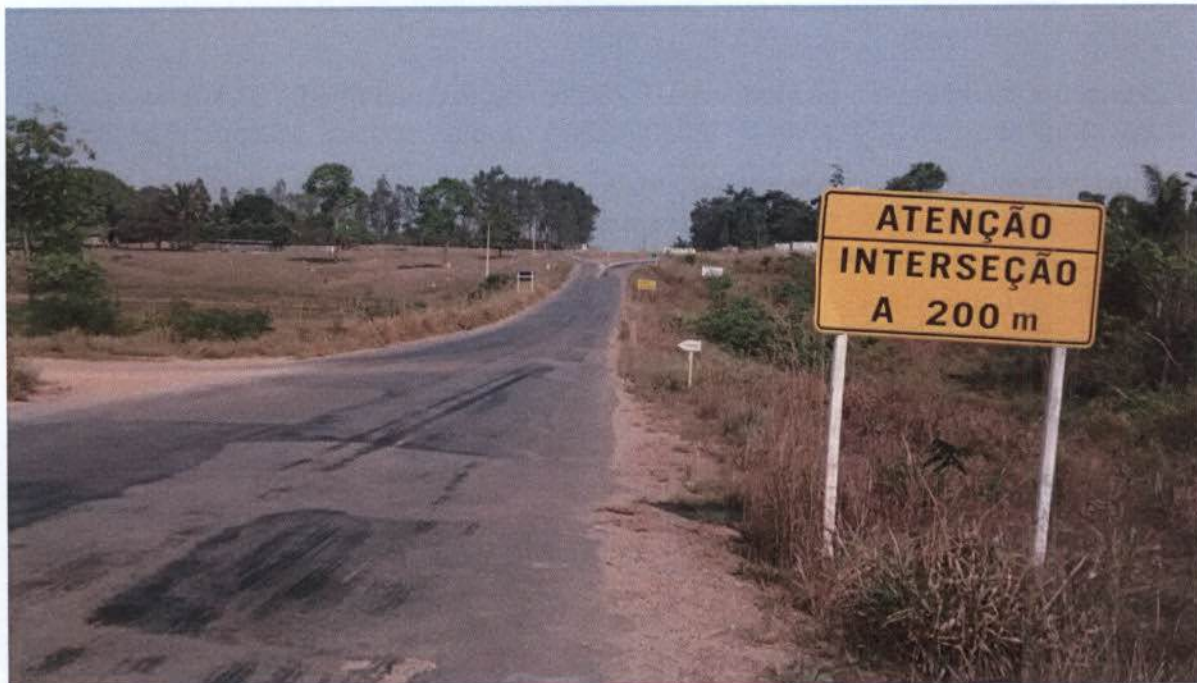
Foto 2-4 – Interseção da Rodovia MT-206 com o acesso a Paranaíta.
