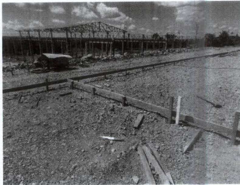
Figura 7: Estruturas de marcação para concretagem e estacas para demarcação.
