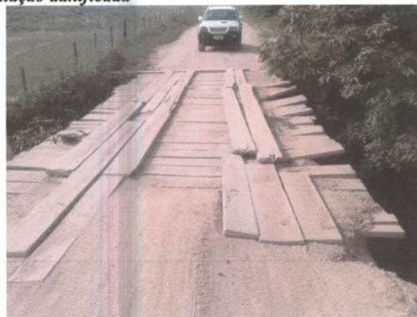
Pontes de acesso ao empreendimento danificadas por excesso de peso
