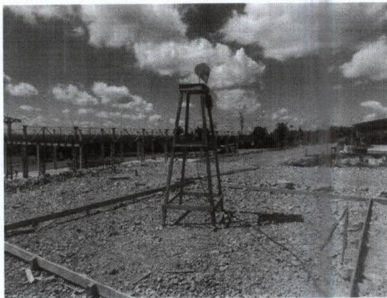
Figura 8: Bases para luminárias, e limitadores para concreto.
