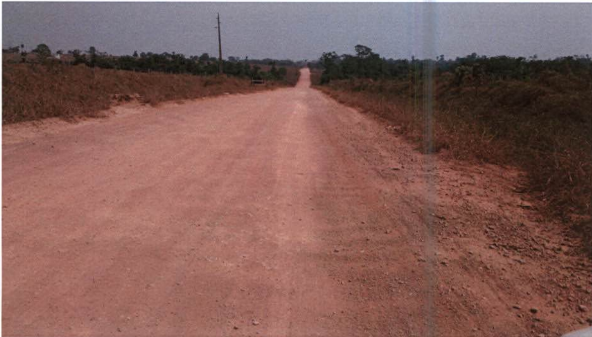
Foto 2-5 – Características físicas da Rodovia MT-206.
