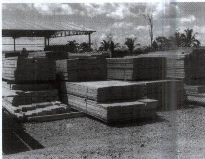
Figura 5: Tábuas adquiridas para utilização no canteiro de obras.
