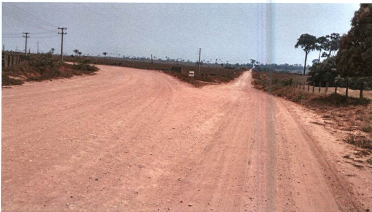
Foto 2-6 – Interseção da Rodovia MT-206 com o acesso a UHE São Manoel.
