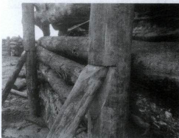
Figura 9: Detalhe detravamento de pilhas.
