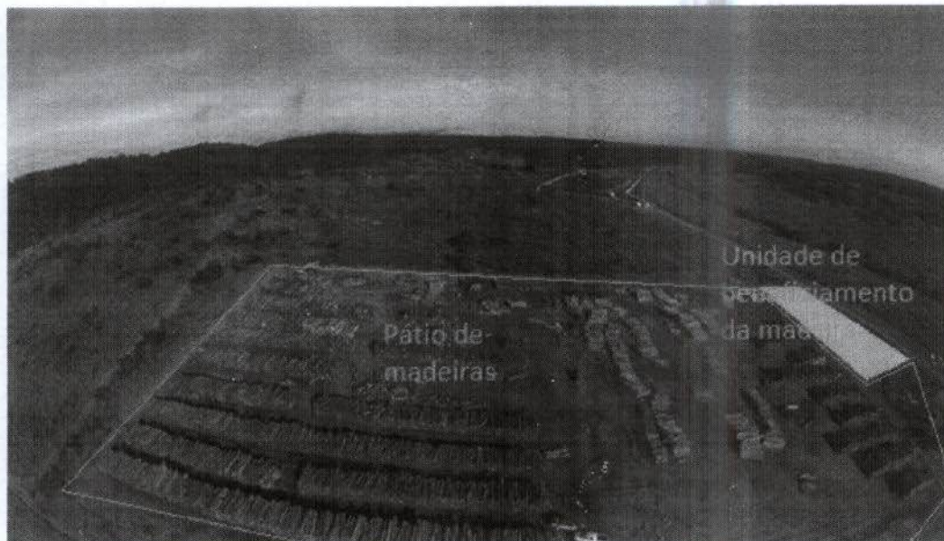
Figura 2: Vista superior do pátio de madeiras com o local de instalação da unidade de beneficiamento em destaque.
