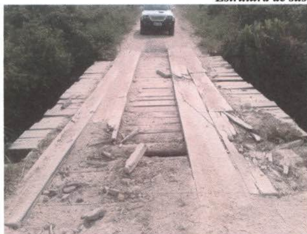
Pontes de acesso ao empreendimento danificadas por excesso de peso
