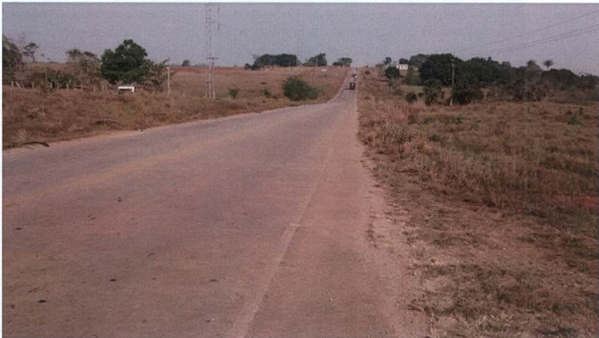
Foto 2-1 – Características físicas da Rodovia MT - 208
