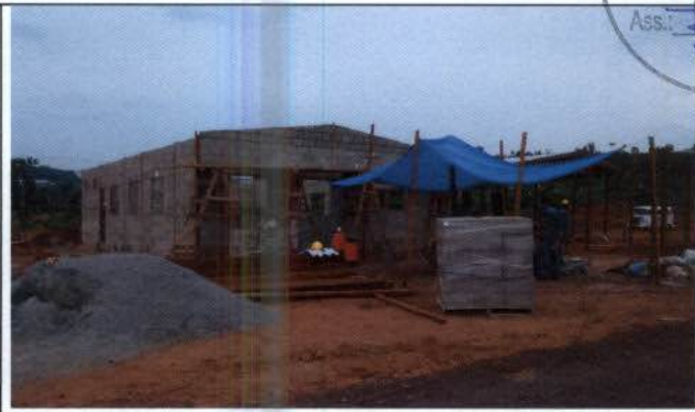
Foto 49 - Instalação do Centro de Triage de Fauna
