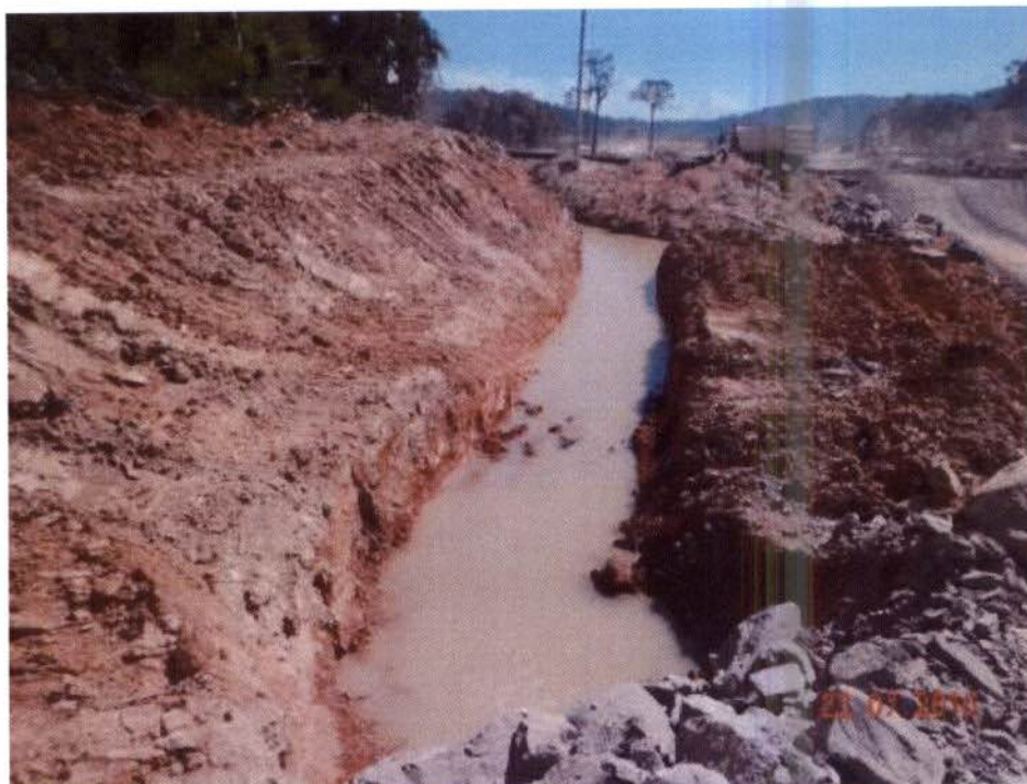
Figura 2: Vista geral do canal do vale e do canal de escoamento por gravidade até o rio Teles Pires.
