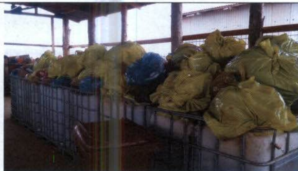
Foto 30 – Galpão de Armazenamento de Resíduos Perigosos.
