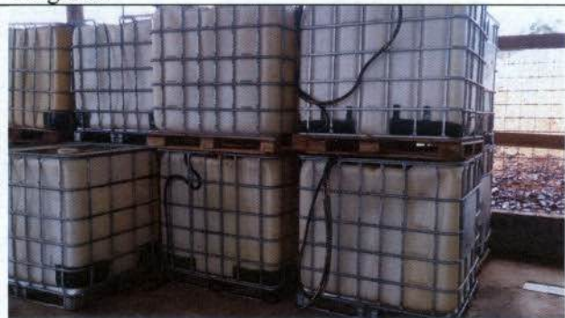
Foto 31 – Galpão de Armazenamento de Resíduos Perigosos.
