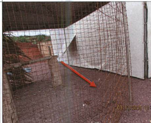
Figura 06: Detalhe na abertura da porta do tratamento, conforme figura 05.
