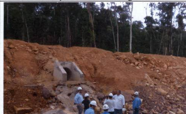
Foto 52 - Passagem subterrânea para fauna
