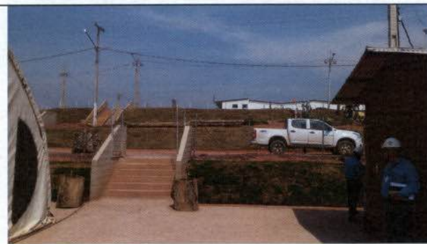
Foto 07 – Plantio de gramíneas e a realização de hidrossemeadura, nos taludes que circunda o refeitório e dão acesso a área de vivência.
