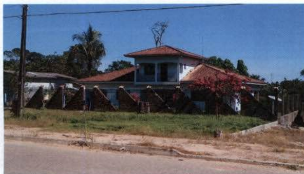
Fig. 03 - Casa que funciona o RH da Constran em Paranaíta/MT.
