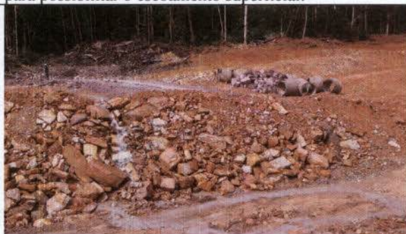
Fig. 50 – Vala aberta entre os resíduos do desmatamento para possibilitar o escoamento superficial.
