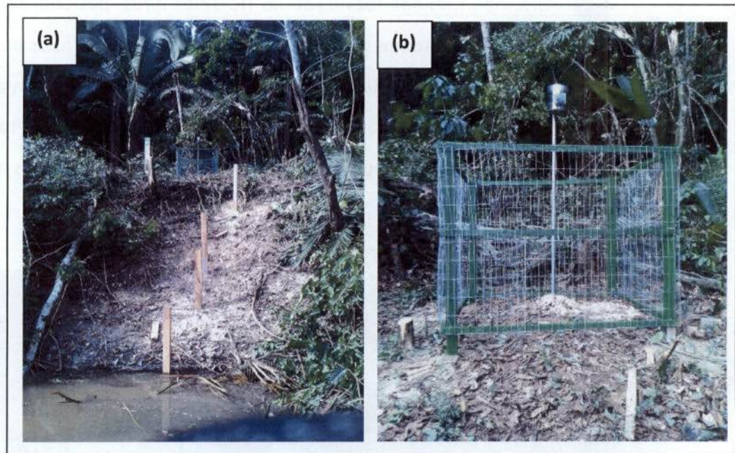
Figura 3. Local de instalação da estação hidrométrica Apiacás.
