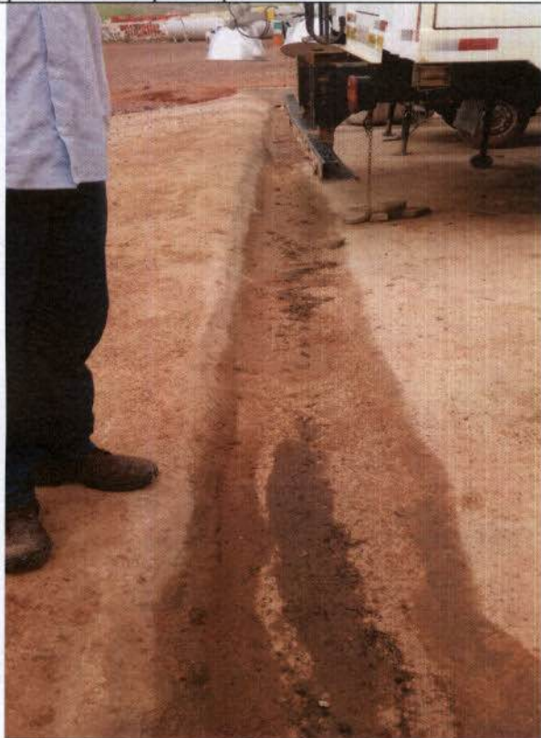
Fig. 25 – Área de troca de fluidos oleosos na oficina provisória com piso impermeável.
