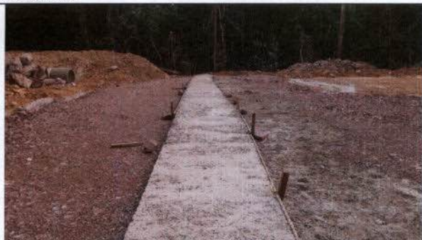
Fig. 51 – Drenagem mantida na área do acesso definitivo.
