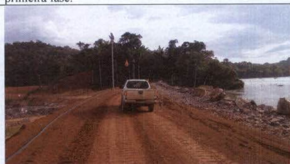
Fig. 45 – Região de águas aprisionadas entre o acesso construído para a ilha e a ensecadeira de montante de primeira fase.
