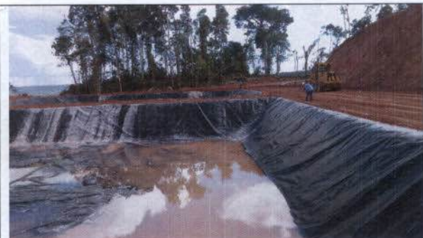
Fig. 43 – Reservatórios de água bruta da ETA do canteiro de obras.
