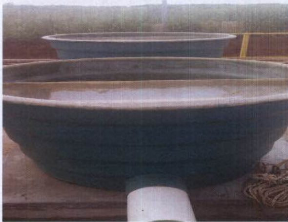
Fig. 55 – Sistema de Tratamento Primário da ETE do canteiro de obras.
