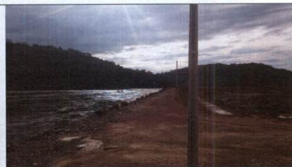
Fig. 46 – Áreas deprimidas nas frentes de obra onde ocorrem acúmulo de águas pluviais.
