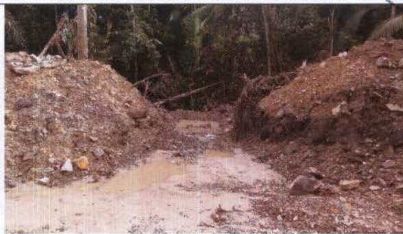
Fig. 50 – Vala aberta entre os resíduos do desmatamento para possibilitar o escoamento superficial.
