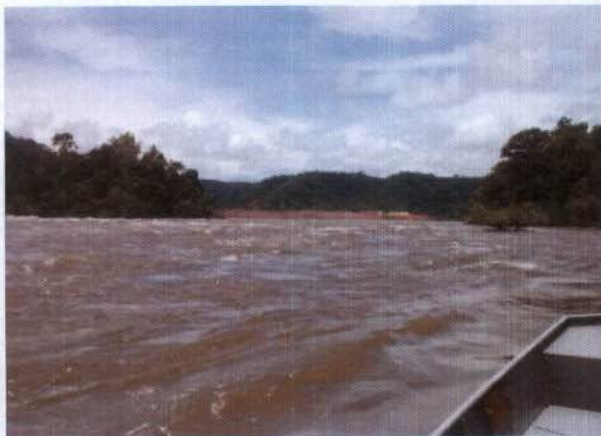
Fig. 07 – Rio Teles Pires. Visão da futura ensecadeira de 2ª fase à esquerda. Ao fundo ensecadeira longitudinal da 1ª área ensecada.
