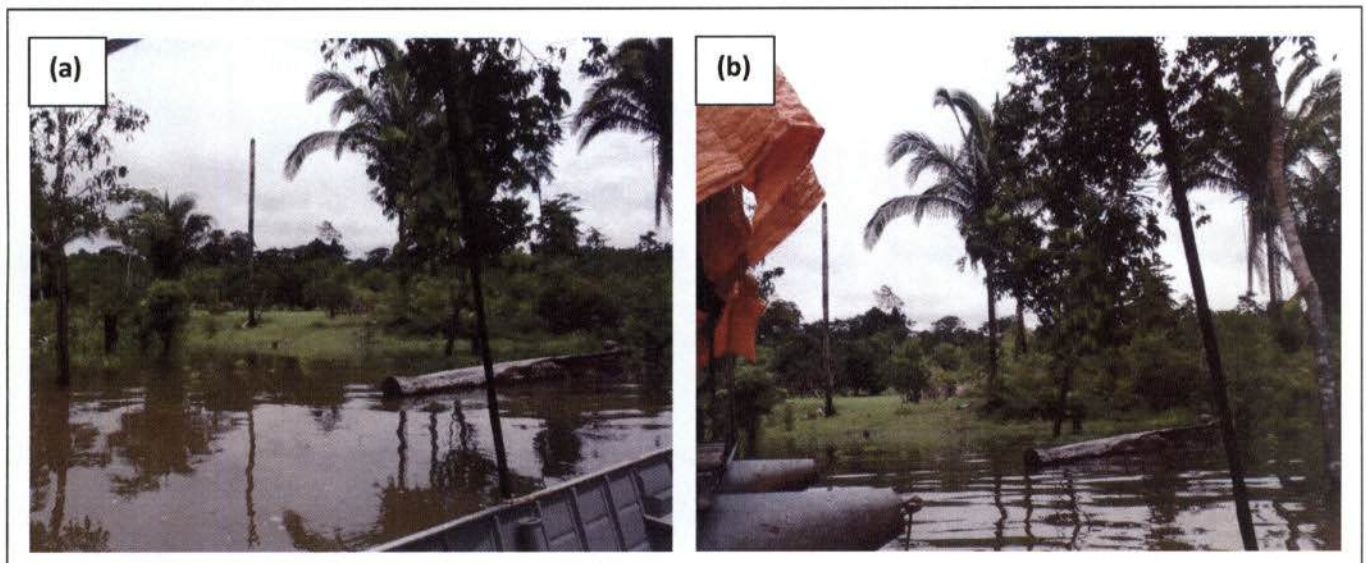
Figura 2. Local de instalação da estação hidrométrica UHE São Manoel.
