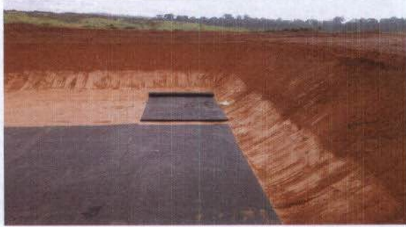
Fig. 31 – Instalação de célula do aterro sanitário.
