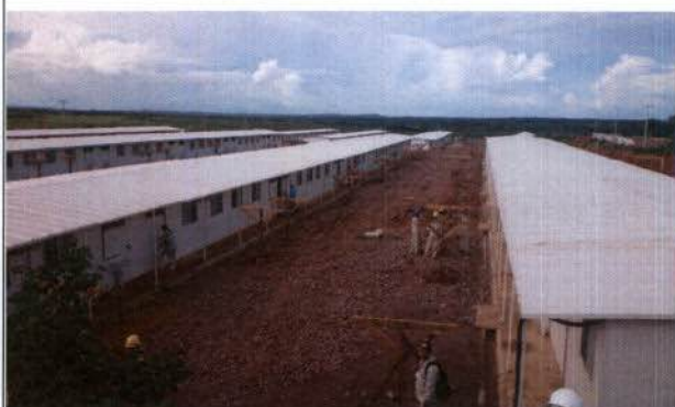
Fig. 17 – Alojamento definitivo para os trabalhadores em construção no canteiro de obras.
