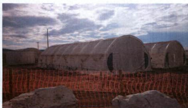
Fig. 15 – Alojamento provisório dos trabalhadores no canteiro de obras.
