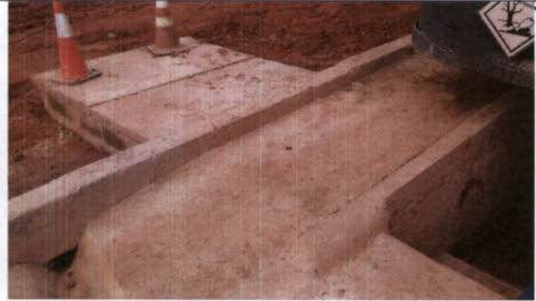
Fig. 26 – Caixa de retenção instalada na área de troca de fluidos oleosos na oficina provisória.
