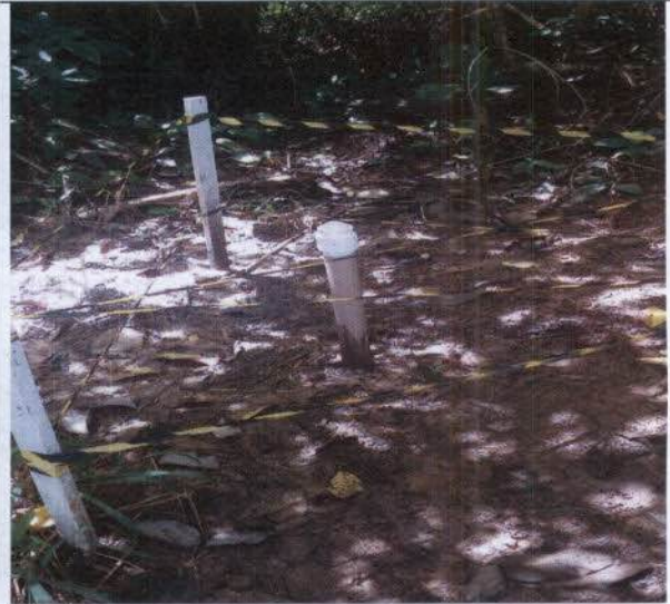
Fig. 56 – Sistema de Tratamento Secundário da ETE do canteiro de obras.
