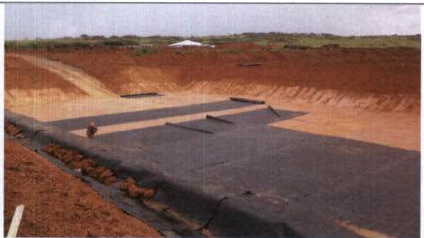
Fig. 30 – Instalação de célula do aterro sanitário.
