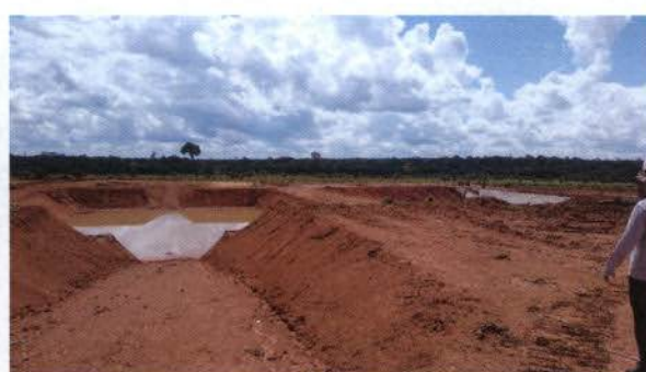
Fig. 06 – Células do aterro sanitário do canteiro de obras
