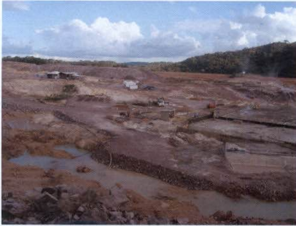
Fig. 07 – Área ensecada para construção da usina
