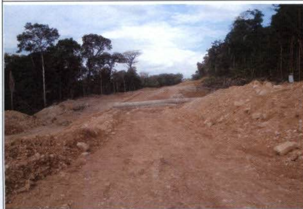
Fig. 15 – Galeria para passagem subterrânea de fauna silvestre.
