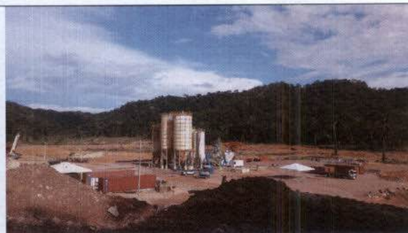
Fig. 44 – Área das Centrais de Concreto e Britagem definitivas.
