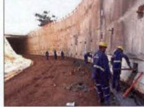
Obras de mobilidade para a copa absorvem muitos trabalhadores
