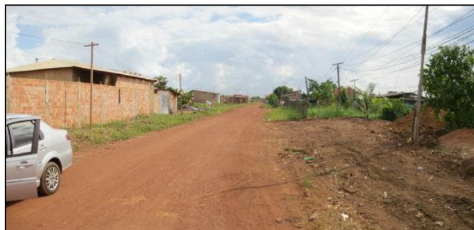
Foto 15: Vista da única via de acesso ao interior da ocupação que recebeu obras de melhoria por parte da prefeitura, nivelamento e cascalhamento.
