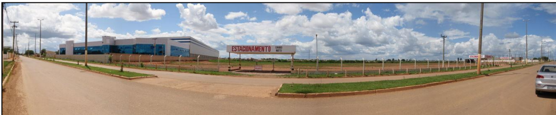
Foto 17: Terrenos lindeiros à Av. Mamoré. Notar, à esquerda, grande galpão em fase final de construção, que abrigará instalações da Distribuidora Coimbra. Ao fundo, a direita na foto, estrutura portante de outro empreendimento em construção.
