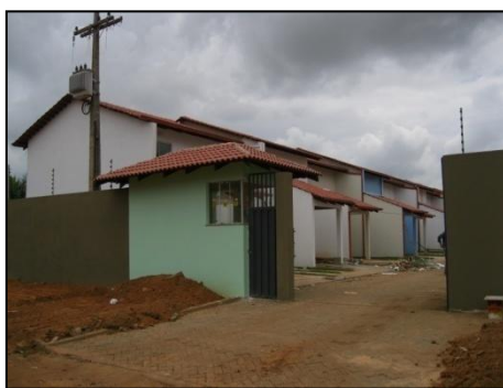
Foto 5: Entrada do condomínio localizado na Estrada da Penal. Notar fase final de execução das obras.
