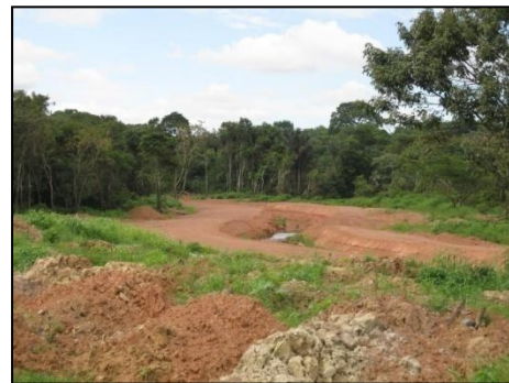
Foto 43: Vista de porção sul da Área. Notar retificação e tratamento do curso d'água.
