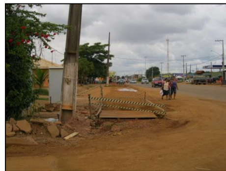
Foto 10: Boca-de-lobo instalada nas proximidades da Av. José Vieira Caúla com Rua Guaporé.
