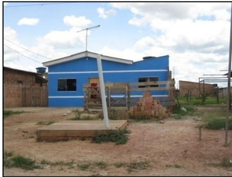
Foto 33: Exemplo de melhoria da edificações que ocorre no Assentamento Porto Cristo.
