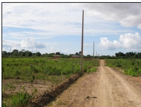
Foto 28: Vista do loteamento localizado a sul da Área 13. Notar edificações sendo construídas.
