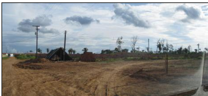
Foto 22: Condomínio de pequenas dimensões sendo construído em terreno às margens da principal via de acesso ao bairro.
