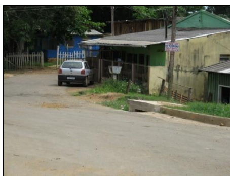
Foto 21: Vista de residências instaladas na Rua Joaquim Nabuco. Perceber boca-de-lobo instalada na via após trabalhos de infraestrutura de drenagem.
