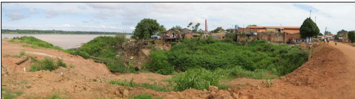
Foto 39: Vista a partir da Rua Madeira Mamoré para oeste. Faixa de desapropriação em área de risco.
