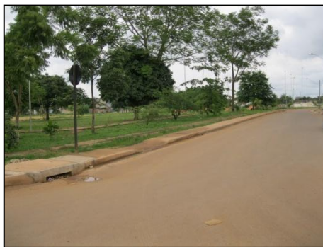
Foto 9: Vista da Rua Marineide que recebeu infraestrutura de pavimentação e drenagem pluvial (notar boca-de-lobo implantada a esquerda da foto).
