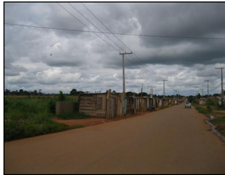
Foto 8: Imagem da Av. Camala, onde estão instaladas 48 famílias retiradas de assentamento irregular em terreno próximo ao local.
