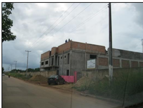
Foto 45: Pequeno empreendimento sendo construído em terreno da porção norte da Área 20.
