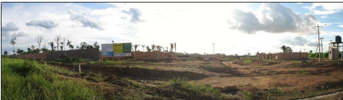
Foto 24: Vista do terreno onde está sendo erguido o Condomínio Nova Era III.
