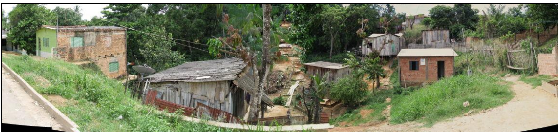
Foto 20: Vista de residências instaladas na Rua Joaquim Nabuco. Notar a no canto inferior esquerdo da foto a implantação de sarjeta, meio-fio e pavimentação asfáltica.
