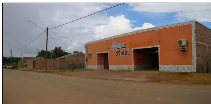
Foto 44: Vista da Rua Piratininga que recebeu pavimentação asfáltica. Notar que não houve tratamento adequado dos passeios, bem como implantação de meio-fio e sarjeta.
