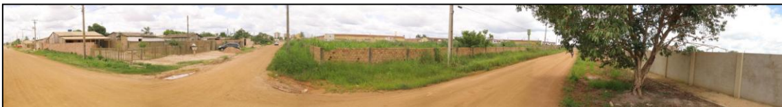
Foto 12: Vista de vias no interior do bairro Lagoa. Ao centro terreno ainda desocupado, à esquerda ocupação residencial que aos poucos se qualifica e à direita muro recém construído limitando terreno anteriormente desocupado (notar estrutura portante de edificação sendo construída no terreno em questão).
