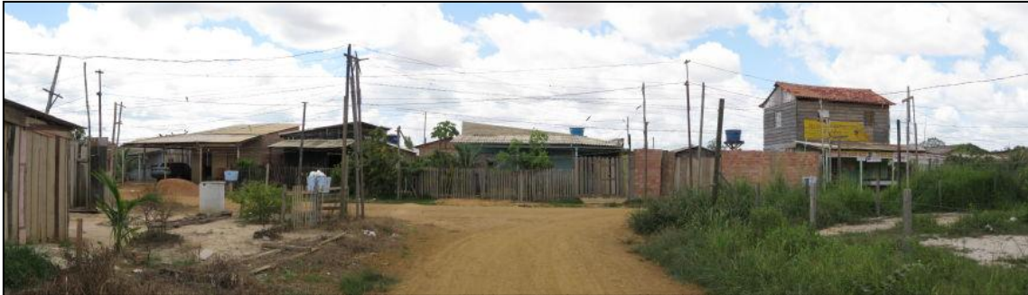
Foto 32: Trecho do Assentamento Porto Cristo que recebeu melhoria da pavimentação das vias, cascalhamento. Notar cestos de lixo nos limites dos lotes, o que evidencia a coleta de resíduos no bairro.
