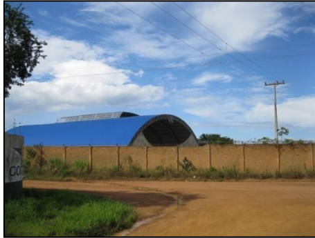
Foto 36: Vista da parte sudeste da Área 17. Notar cobertura da quadra poliesportiva construída no terreno.
