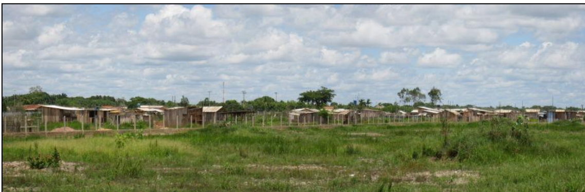
Foto 30: Nova ocupação ao sul do limite da Área 16. Continuidade do processo de ocupação sem muita alteração das características predominantes na área.
