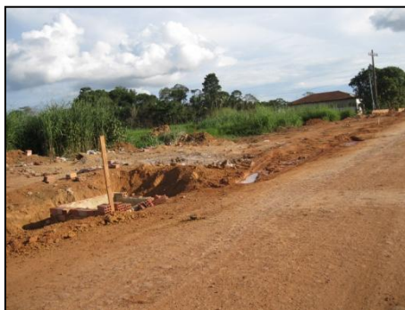
Foto 25: Intervenções para instalação do sistema de drenagem na principal via de acesso ao bairro.
