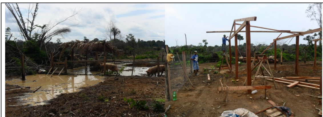
Figura 04. Lote 73 – Infraestrutura atual e a nova instalação com orientação do ATEs. Fonte: EMATER-RO.
